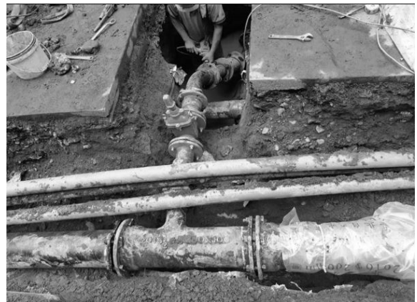
圖 11 自來水管穿越管障
