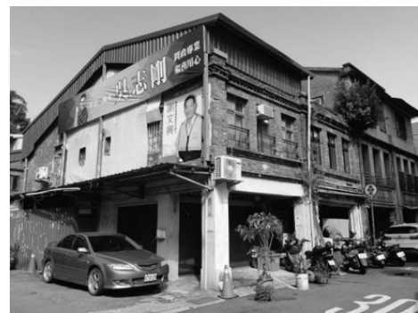
圖 1 小區內現況房屋老舊
