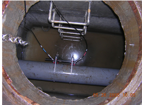
圖二：計量窰井與管夾式 sensor
