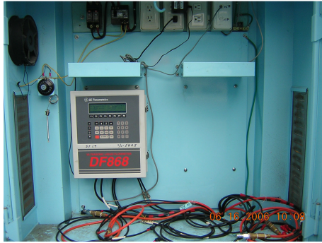
圖一：線上超音波計量的傳訊設備
