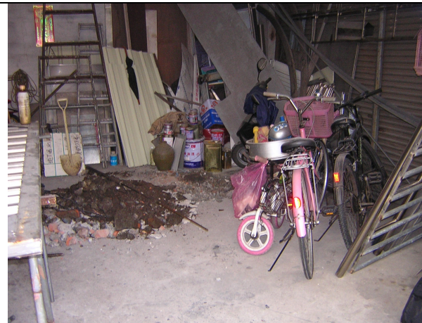
圖十六：位於屋內，搬移堆積的雜物後，漏水點開挖情形。
