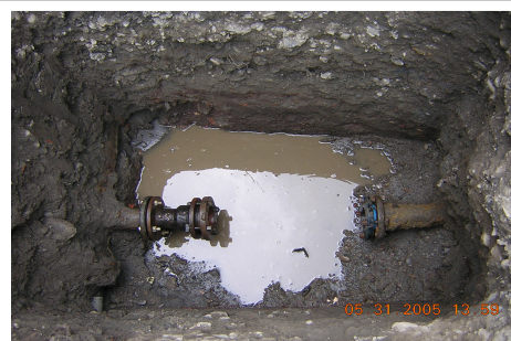
圖十五：兩端封閉隔離
