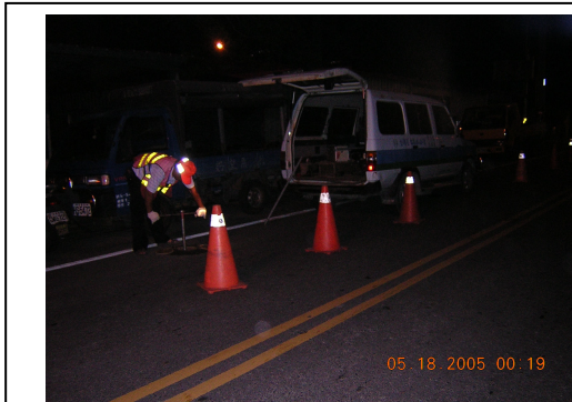
圖十：關閉隔離的制水閥
