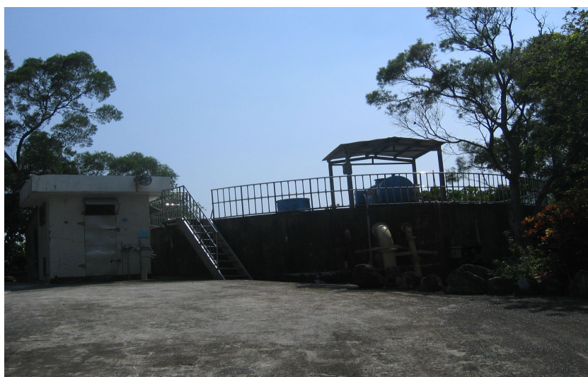
照片 11 宜蘭南澳供水系統 500 噸配水池照片
