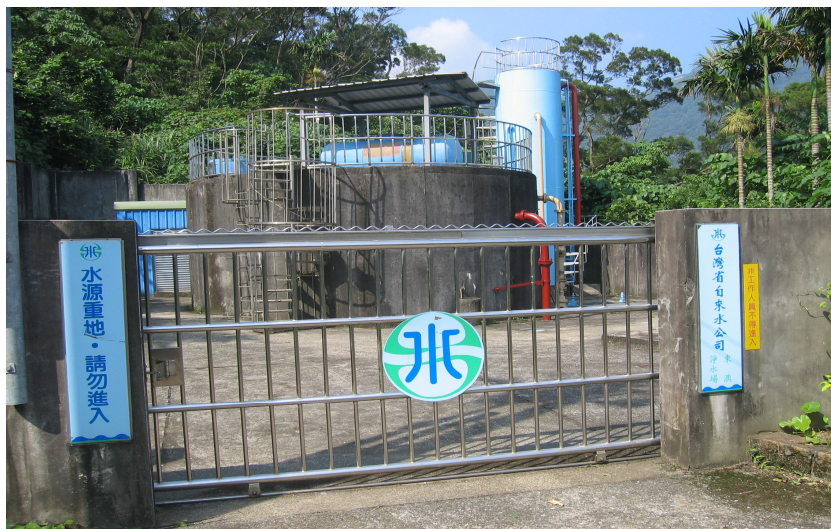
照片 7 宜蘭東澳淨水場之配水池照片
