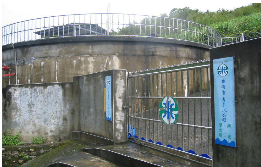
照片 4 宜蘭澳花系統 400 噸配水池照片
