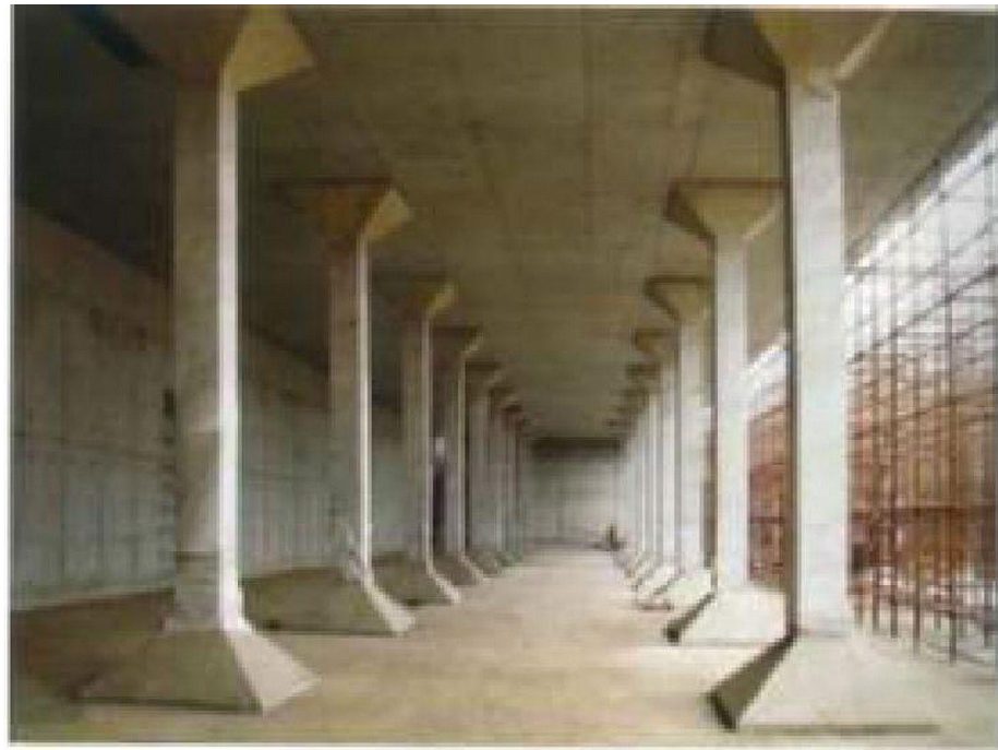
圖 5-10 施工中的清水池
