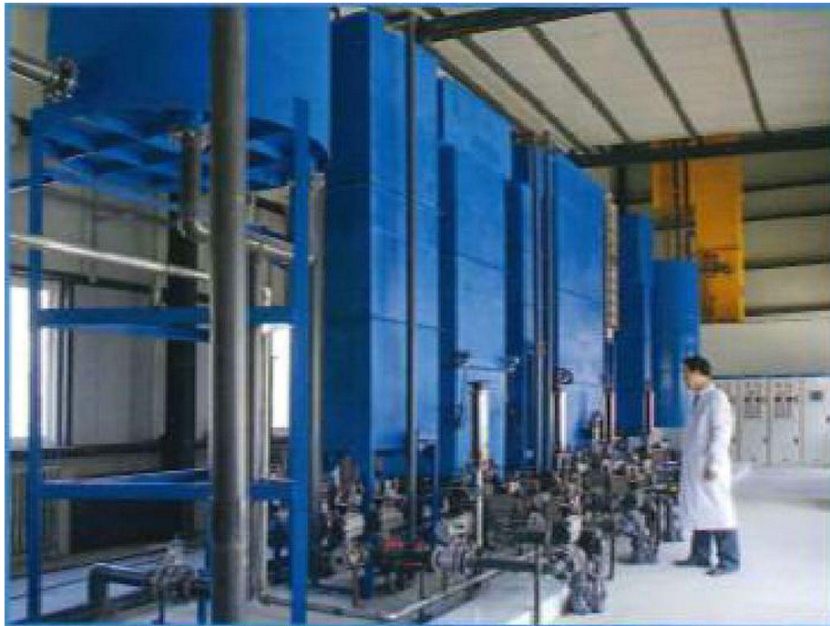
圖 5-4 第 9 水廠建立膜處理中試基地
