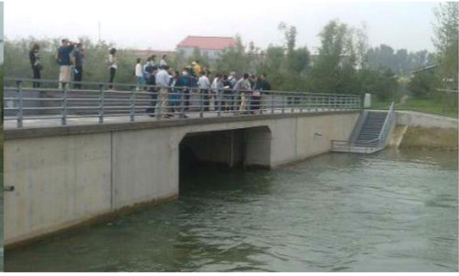
圖 5-21 團城湖明渠轉暗渠段
