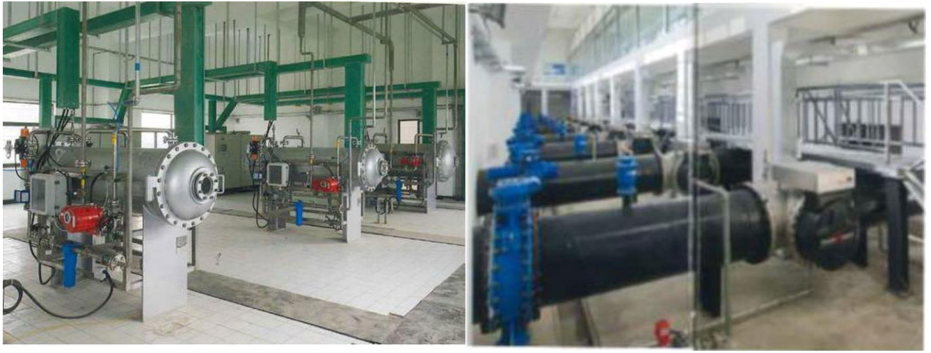
圖 5-9 臭氧設備間與紫外線消毒廠間內景
