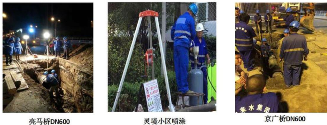
圖 4-8 北京管網改造的現場施工照片 [資料 1]
