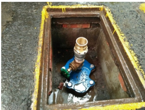
圖 35、地下式消防栓改裝探頭插入接頭及探頭
