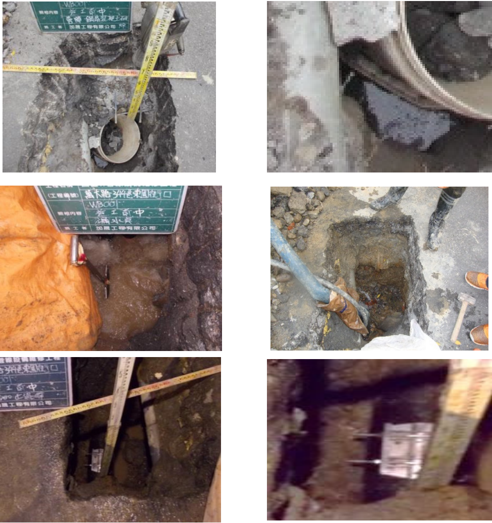
圖 81、漏水位置開挖清理並完成修復
