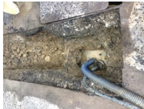
(p)B 區修漏開挖係 \phi 20-PEP 脫接漏水
