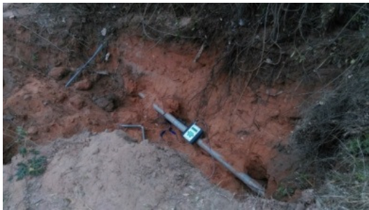
(a) 開挖 A 點 - 無漏水
