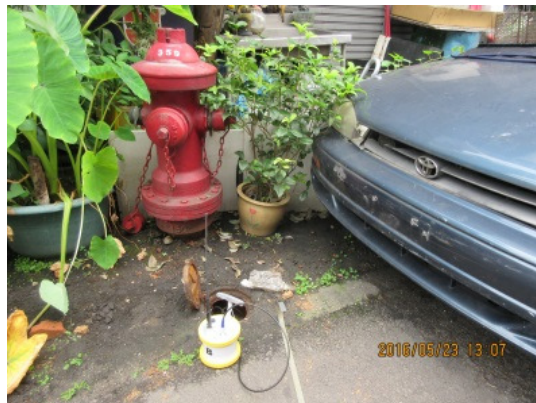
(k) 噪音記錄器判讀漏水處，管段兩端裝設感測器
