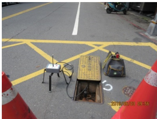
(h) 噪音記錄器判讀漏水處，管段兩端裝設感測器 B
