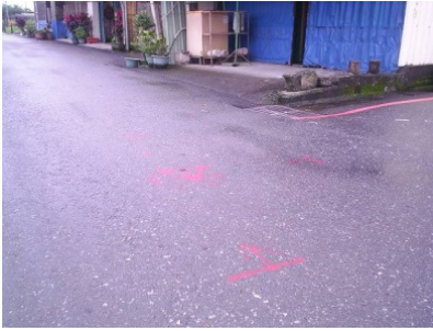
10. B 漏水點-3 巷 12 號， \phi 50 塑膠管考克接頭漏水
