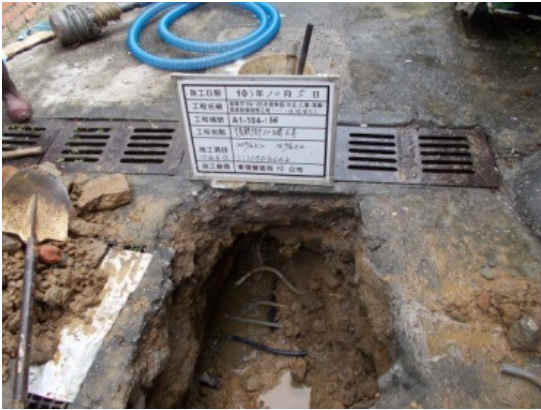
(a) CH 管段於 113 巷 6 號漏水點開挖修復
