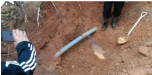
(c) 開挖 C 點 - 無漏水
