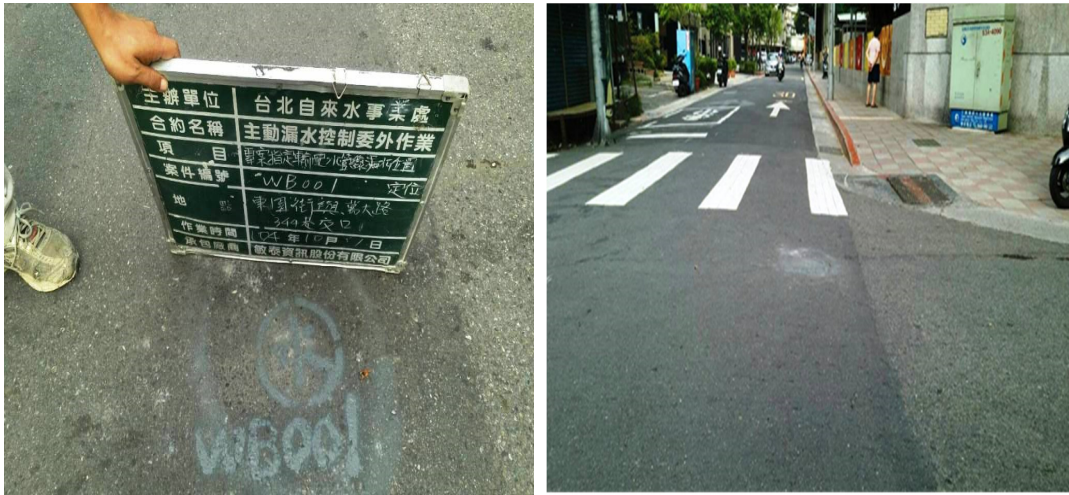
圖 79、管線漏水位置定位點標示
