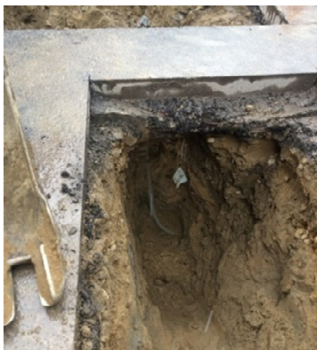
(n)A 區修漏開挖處無漏水，惟仍有漏水音待複測
