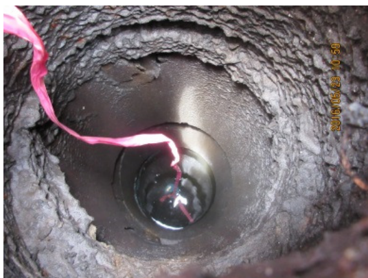
(d)制水閥帽置放浸水式噪音記錄器
