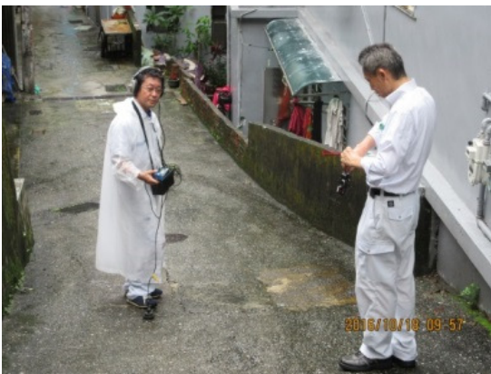
(e) 經聽音複測，確認於 113 巷 12 號外線分歧點處漏水
