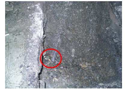
10. B 漏水點-3 巷 12 號， \phi 50 塑膠管考克接頭漏水
