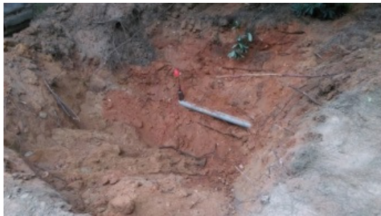
(c) 開挖 C 點 - 無漏水
