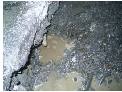
11. C 漏水點-3 巷 1 弄 9 號- \phi 20 接合管穿孔漏水 圖 63、宜蘭縣冬山鄉日新小區成功案例
