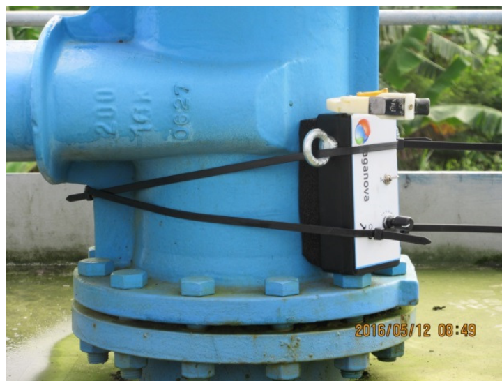
圖 22、排氣閥安裝同步器圖
