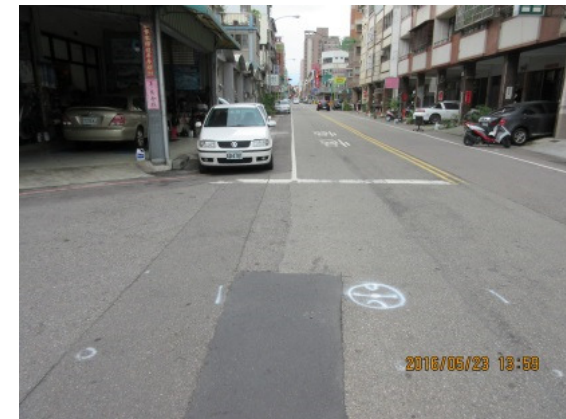
(j) 噪音記錄器判讀漏水處，管段兩端裝設感測器
