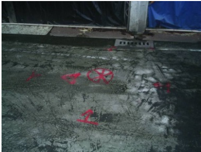
10. B 漏水點-3 巷 12 號， \phi 50 塑膠管考克接頭漏水
