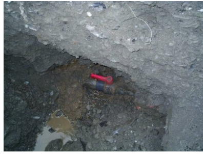
10. B 漏水點-3 巷 12 號， \phi 50 塑膠管考克接頭漏水
