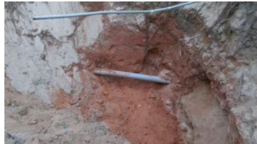
(b) 開挖 B 點 - 無漏水
