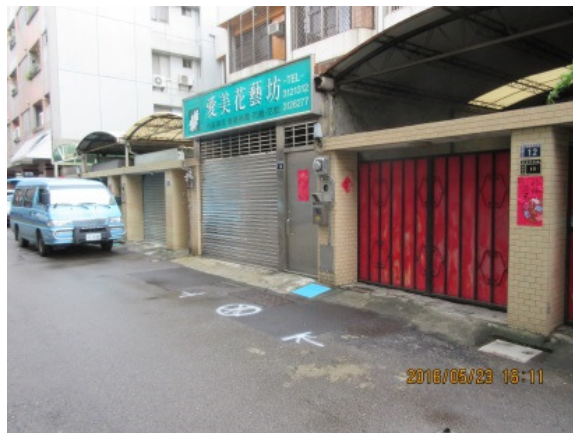
(o) B 區疑似漏水點噴漆註記
