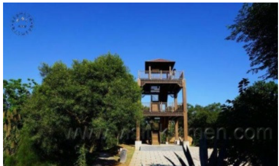
(f)最高點麒麟山放置-無線電接收&GPRS 遠端傳訊，回傳至美國監漏中心
