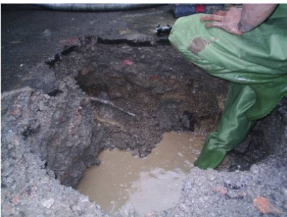
9. A 漏水點-2 巷 23 號， \phi 20 接合管管套節鉛管焊接點穿孔漏水
