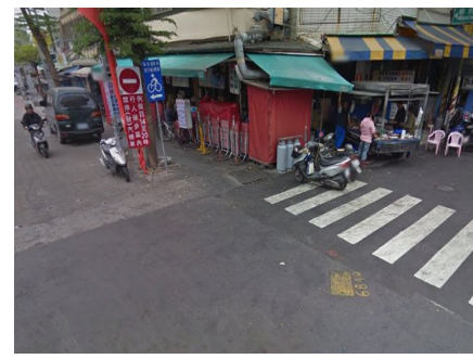
(g)廟前路 2.5 公尺漏水點
