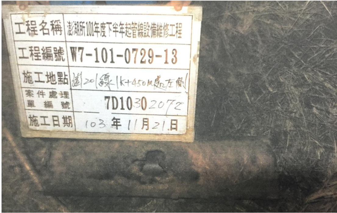
圖 3-5 澎湖地區 DIP 修漏現況照片
