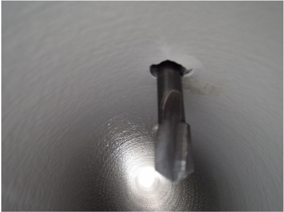
圖4-25 「十字鑽孔機」鑽破水泥襯裡及密封塗層
