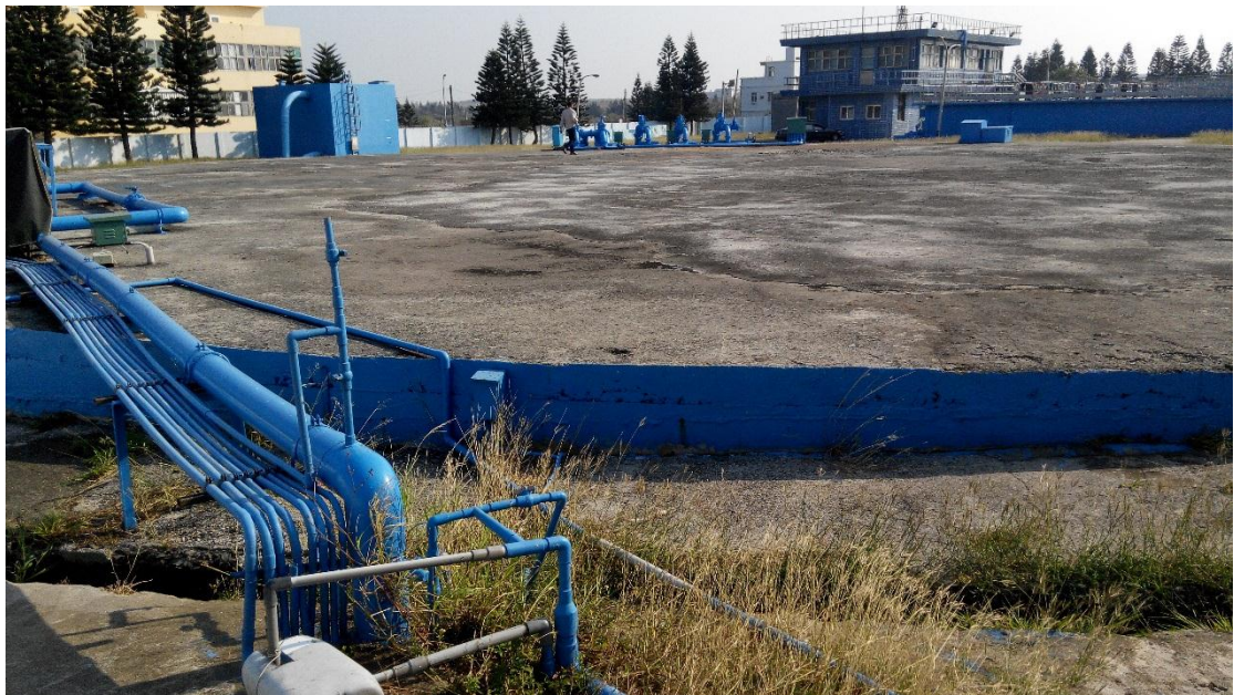
圖 3-12 鹽井淡化水試驗組（成功淨水場），現況照片
