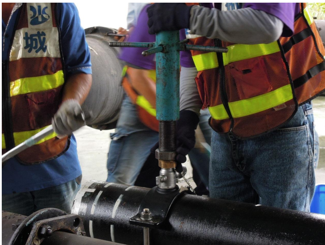
圖4-24 「十字鑽孔機」安裝分水鞍
