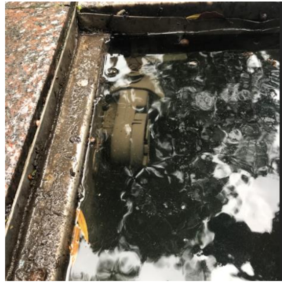
圖 5-44 用戶窰井排水孔堵塞未處理淹沒已置頂的傳輸設備
