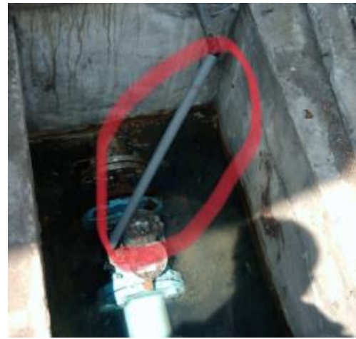
5-48 通訊線加裝 PVC 管防護
