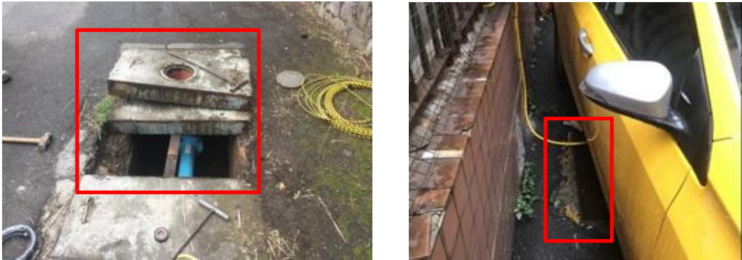
圖 5-40 表箱過厚或表位停車造成訊號不良
