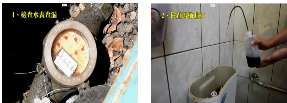
圖 4-2 檢查水表計量及檢查馬桶漏水
