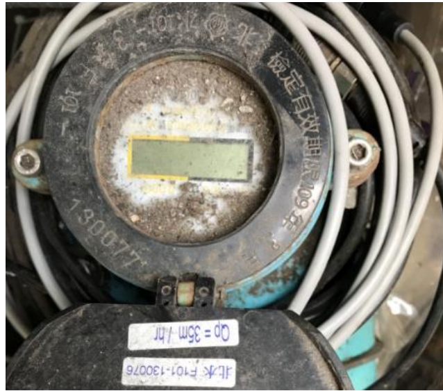
圖 5-38 壞表造成計量數據無法傳送
