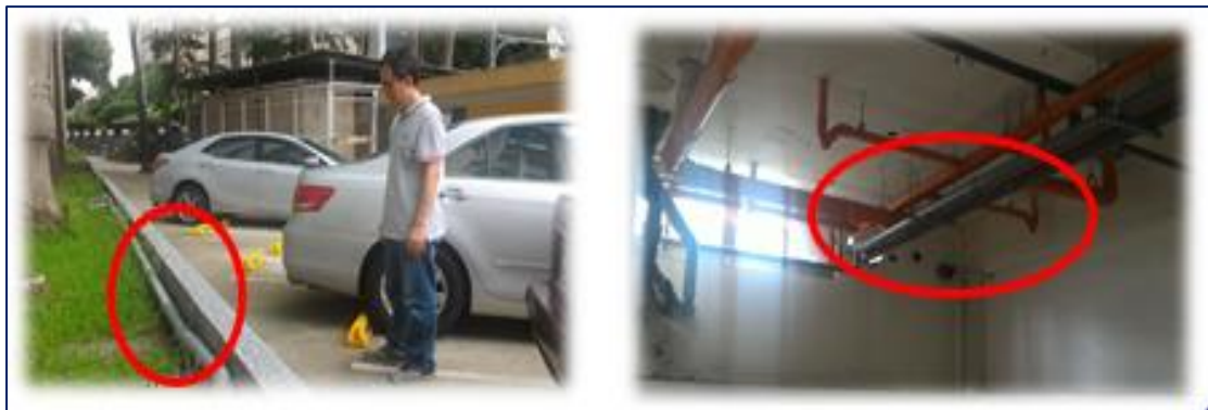
圖 5-84 學校將漏水暗管改為明管
