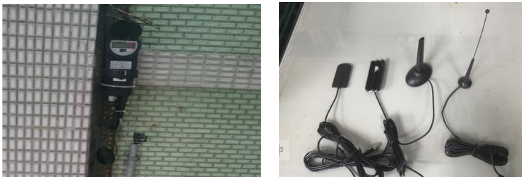
圖 5-41 依現場環境進行傳輸設備外移、天線改善與換裝
