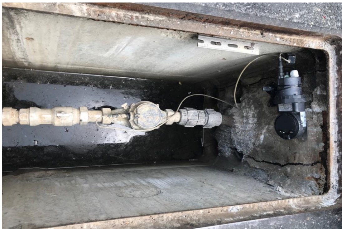
圖 5-43 將傳輸設備提高設置於水表箱最上緣
