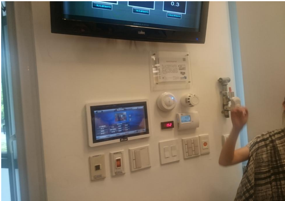
圖 30 智慧化設備(照度、溫度、濕度等自動控制及瓦斯測漏遮斷)
