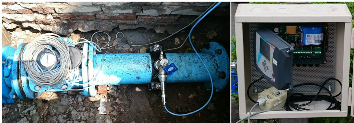
圖 43 國外 I 廠商 WaterMind 之 AMR 系統架構、後端介面與北水處測試照片
