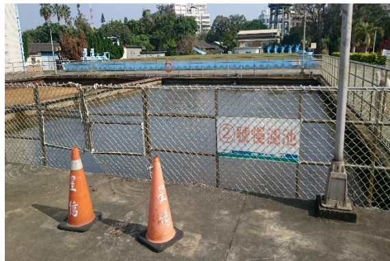
圖 4.4-40 虎尾場 2 號慢濾池
