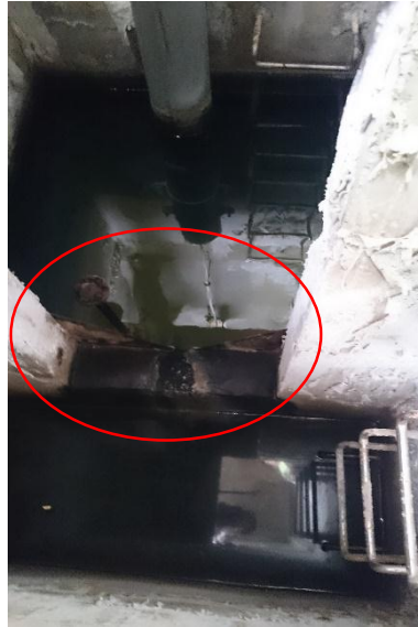
圖 4.4-47 吉貝場濾水溢流堰照片
