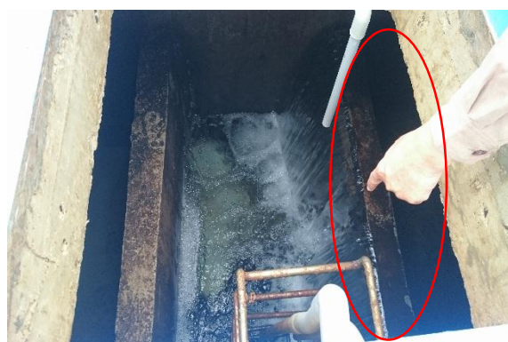
圖 4.4-59 西嶼場濾水溢流堰照片
