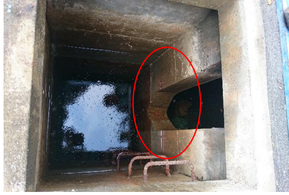
圖 4.4-76 愛國埔場濾水溢流堰照片
