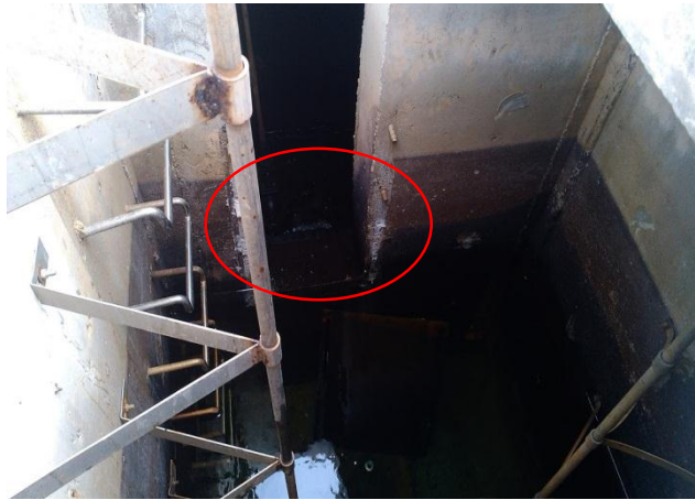
圖 4.1-44 改善前(水位位於砂層下方)
