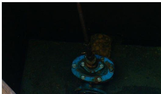
圖 4.1-55 濾水閘門開關
