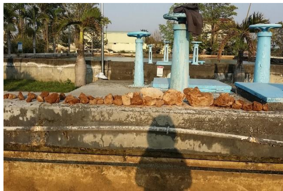
圖 4.4-29 西螺場濾池開挖結塊情形
