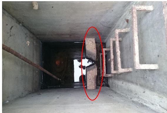
圖 4.4-94 泰源場濾水溢流堰照片
