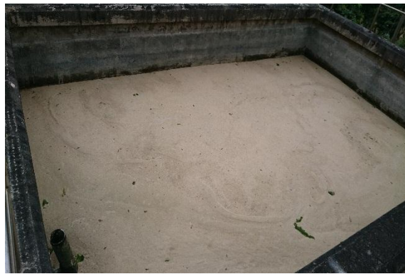
圖 4.4-77 愛國埔場慢濾池輪替操作現場照片
