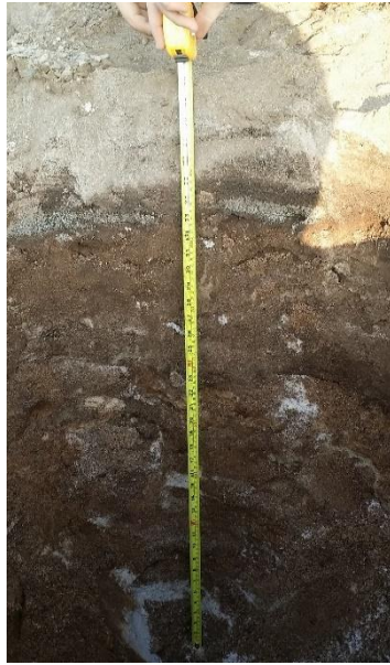
圖 4.4-28 開挖濾池濾層剖面圖(挖掘深度 1m)
