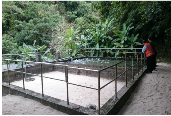
圖 4.4-61 大溪淨水場慢濾池現場圖
