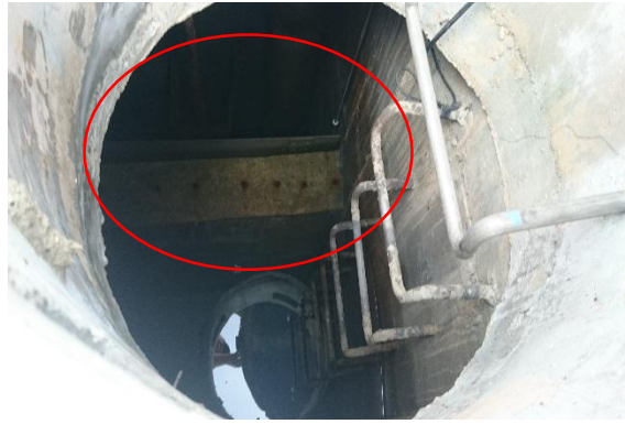
圖 4.4-86 永安場濾水溢流堰照片
