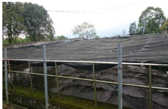
圖 4.4-78 永安淨水場慢濾池現場圖
