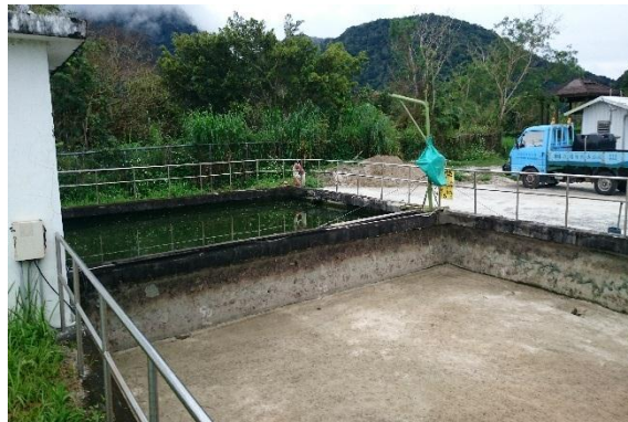
圖 4.4-87 泰源淨水場慢濾池現場圖
