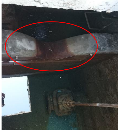
圖 4.4-25 西螺場濾水溢流堰照片
