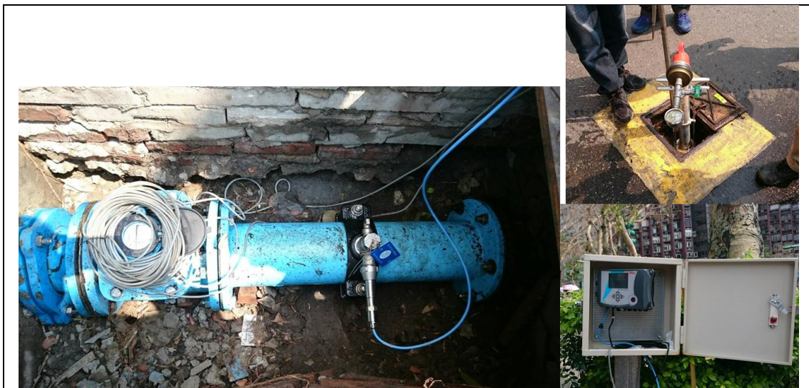
圖 4-19 A 牌自動讀表結合水壓計安裝(消防栓水壓量測檢核)
