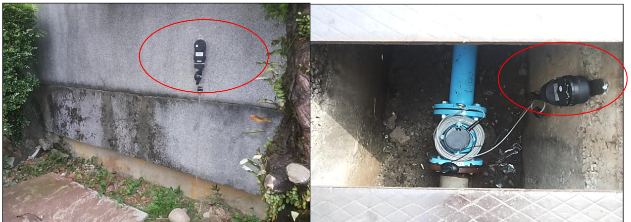
圖 4-5 無線傳輸介面可置入表箱內或直接取代現有遠隔顯示器
