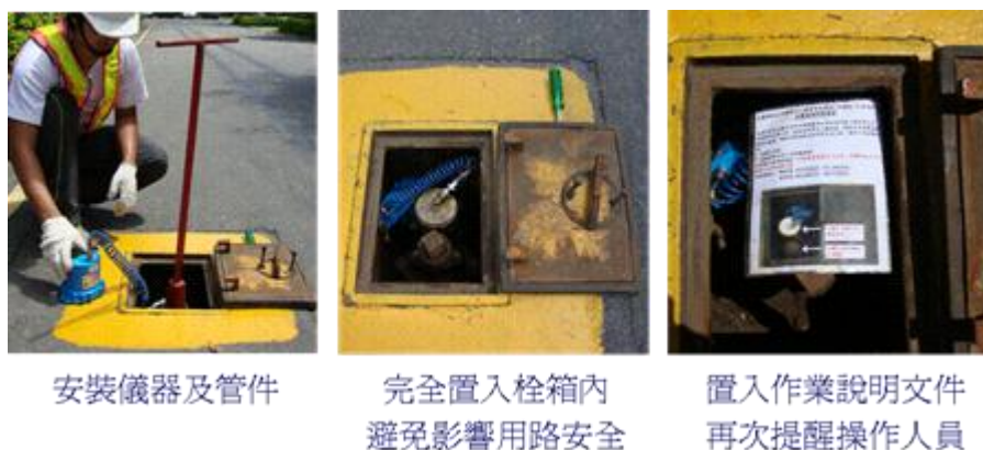
圖 2-11 消防栓現場安裝水壓計量測作業 (資料來源：彭伊呂、鄭答振「水壓調查及等壓線 GIS 圖資系統應用」(2010))
