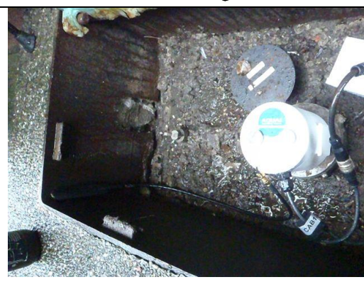
圖 5-36 乙廠商無線讀表裝置民生東路 4 段 80 巷安裝完成照片
