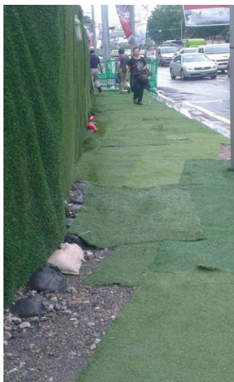
工地邊緣臨時鋪面
