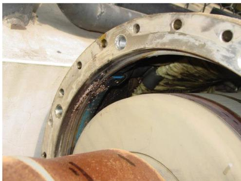
圖 3-6 馬達線圈有燒毀熔珠現象
