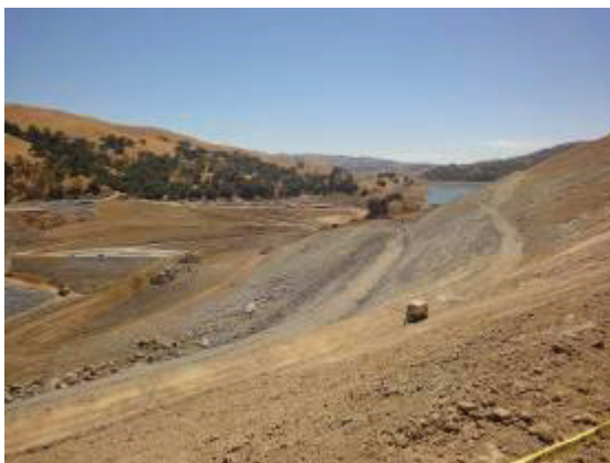
圖 4.3-8 舊壩及新壩施工情形
