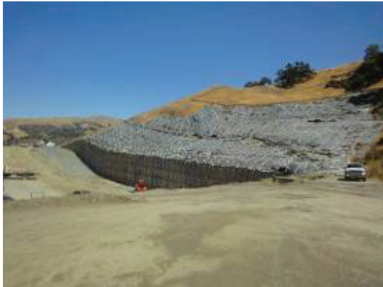
圖 4.3-6 右岸坍塌邊坡以地錨暫時穩定
