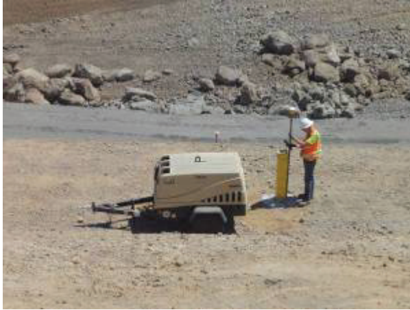
圖 4.3-10 邊坡設立水準監測點
