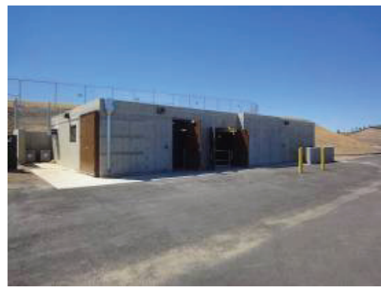
圖 5.1.1-16 中繼 hydro 水力發電站
