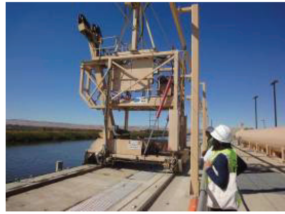
圖 5.1.1-12 自動清除取水口雜物設備
