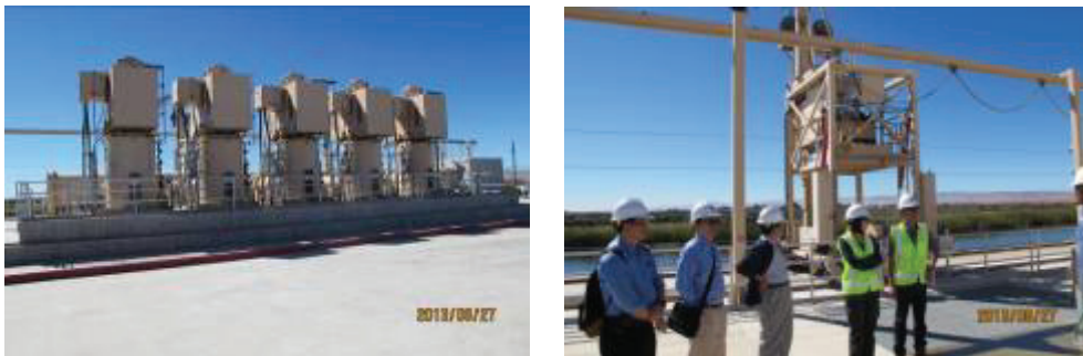
圖 5.1.1-6 5 台 3000HP 豎軸式渦輪幫浦
