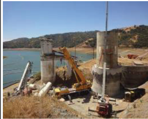
圖 4.3-7 右側新進水口(INTAKE)施工
