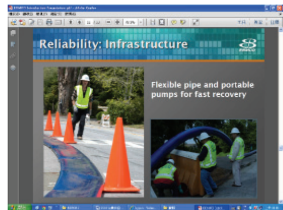
圖 5.2.1-15 移動式抽水機快速修復軟管
