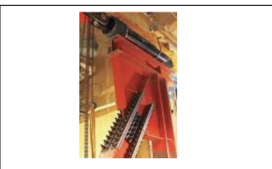
圖 5.2.2-21 管理大樓新增阻尼器
