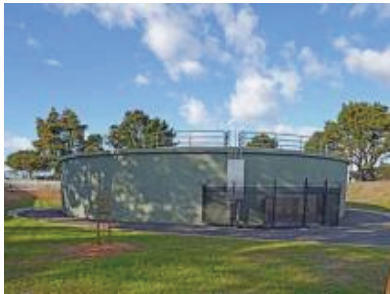
圖 5.3.1-4 混凝土製儲水槽
