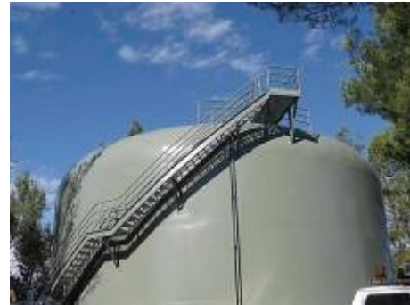
圖 5.3.1-3 鋼製(Steel)儲水槽
