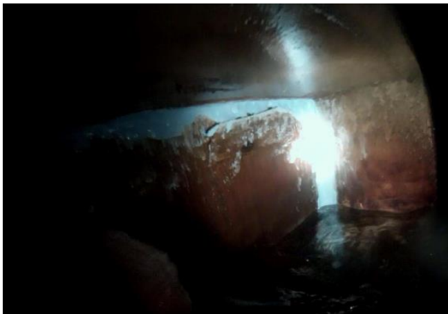
5.伸縮縫填補中
