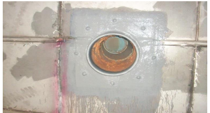
2. 以無毒 FRP 包覆進出水口
