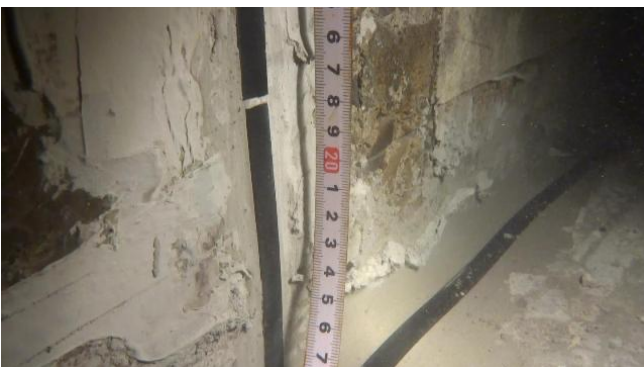
9.橡膠條安裝完成
