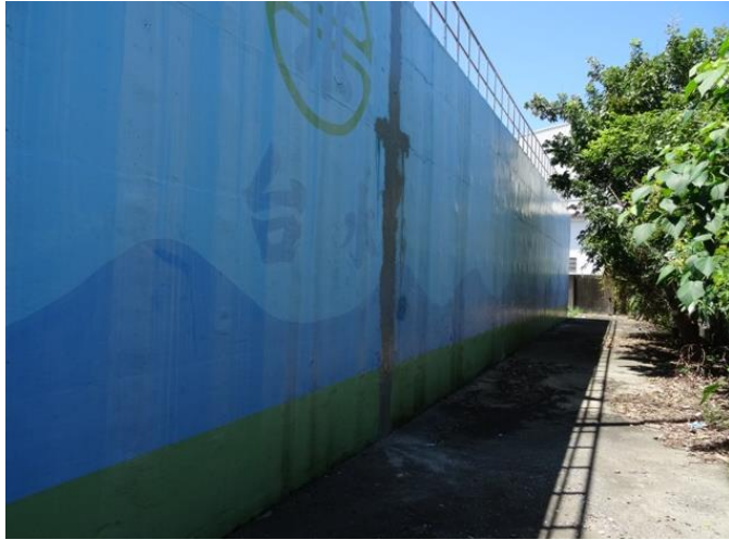
11.修復完成地面無潮濕
