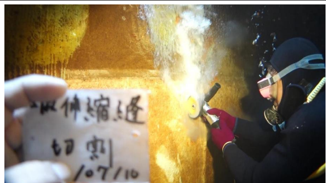
5. 池牆 FRP 切割
