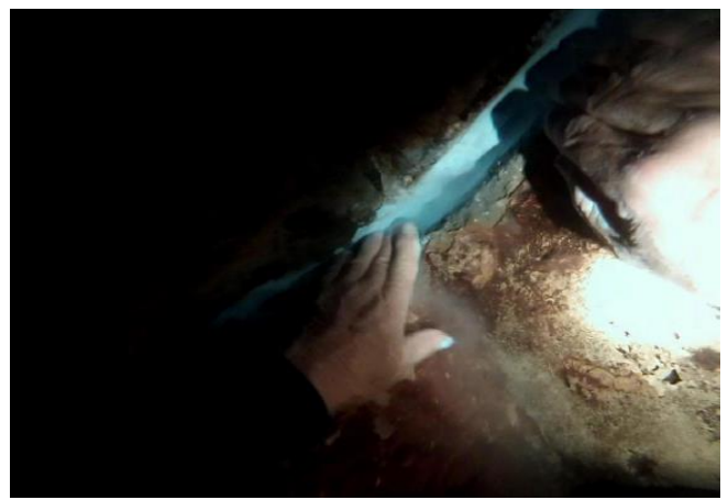
6.伸縮縫填補中
