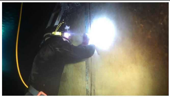
8.橡膠止漏條安裝
