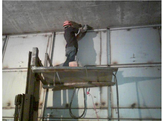
4.鋼板包覆施工
