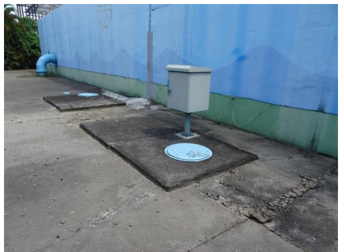
10.修復完成地面無潮濕
