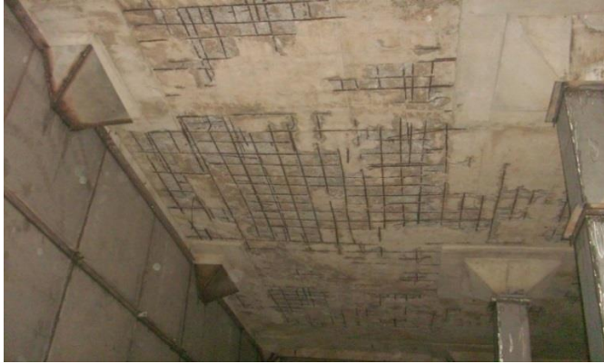
3. 敲除混凝土
