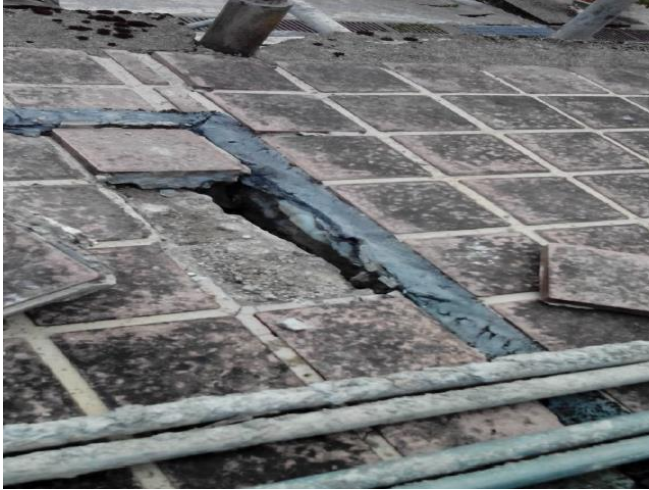
1. 池頂舊有面材打除
