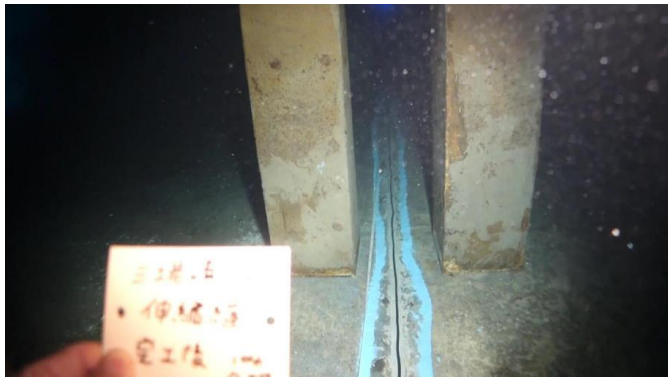
9.橡膠止漏條安裝完成
