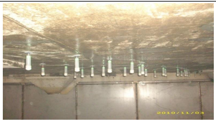
6. 裂縫注射環氧樹脂
