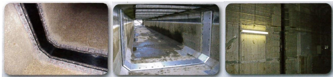
圖 2-7 橡膠壓條完工示意圖
