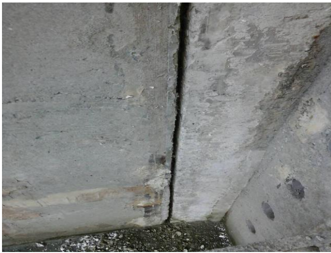
3. 舊有伸縮縫打除
