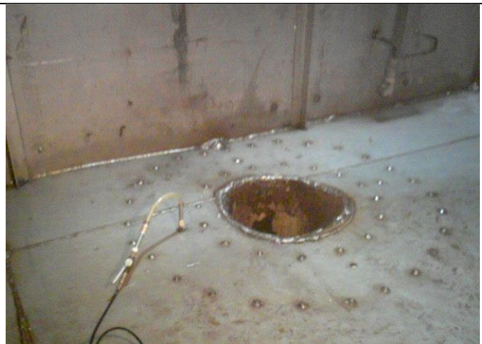
6.底板出水口灌注液態膨脹止水劑
