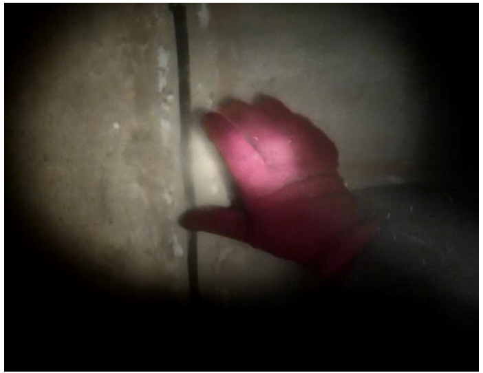
8.橡膠止漏條安裝完成
