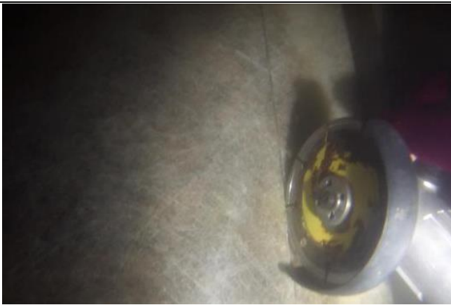
3.舊有 FRP 切割
