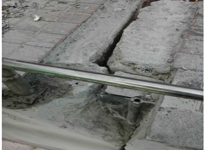
2. 池頂舊有面材打除
