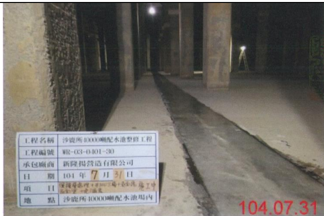
7.FRP 施作完成
