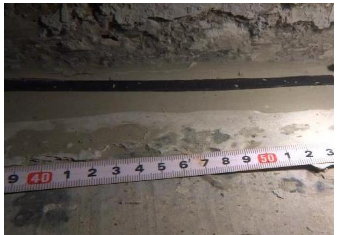
8.橡膠條安裝完成
