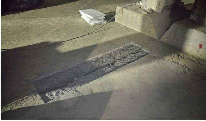
3.玻纖混凝土填溝
