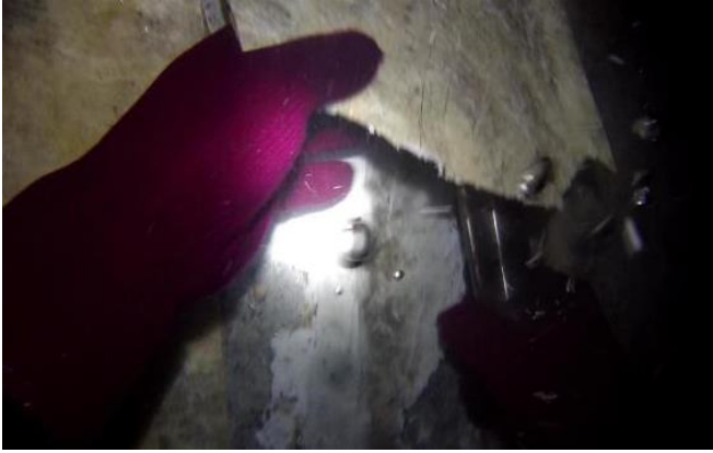
5.舊有 FRP 拆除
