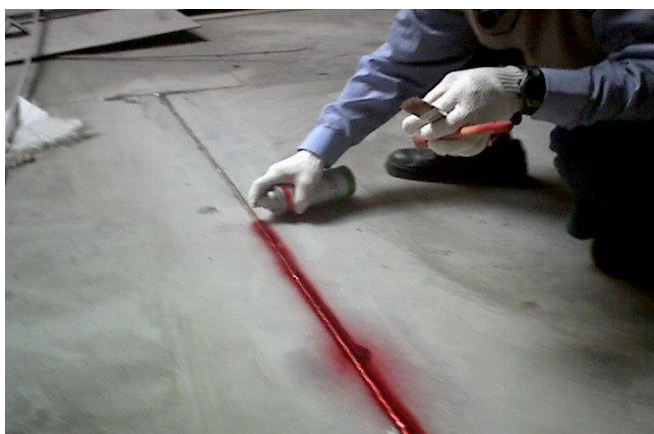
7.焊道非破壞性檢測
