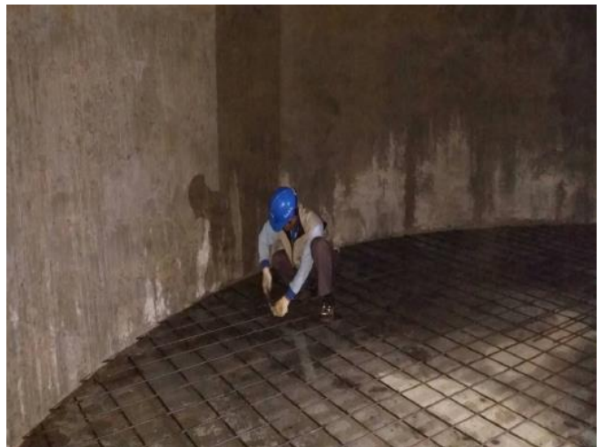
6. 池底鋼筋綁紮
