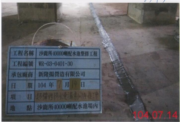
5.彈性填縫劑填補完成
