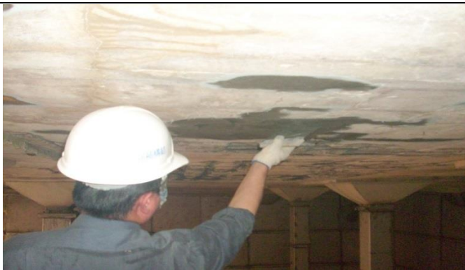
5. 混凝土補強
