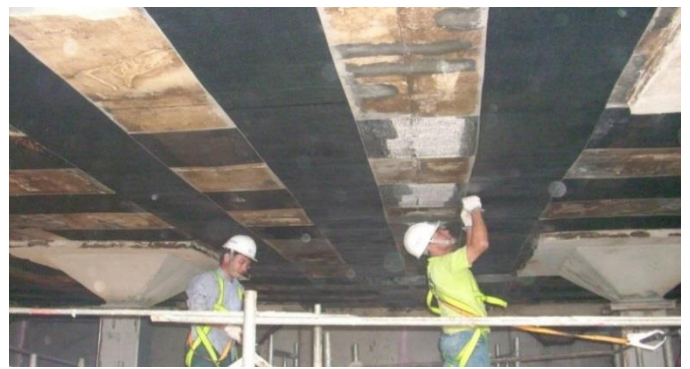
8. 碳纖維貼片黏貼施作
