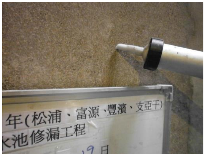
3. 水性填縫膠修補裂縫
