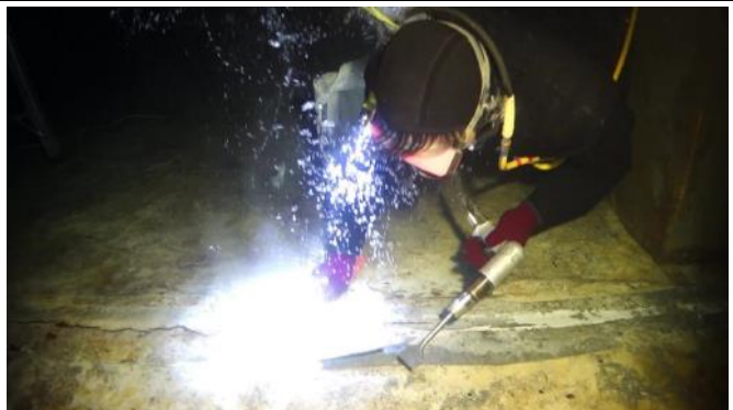
6. 池底伸縮縫鑿除清理
