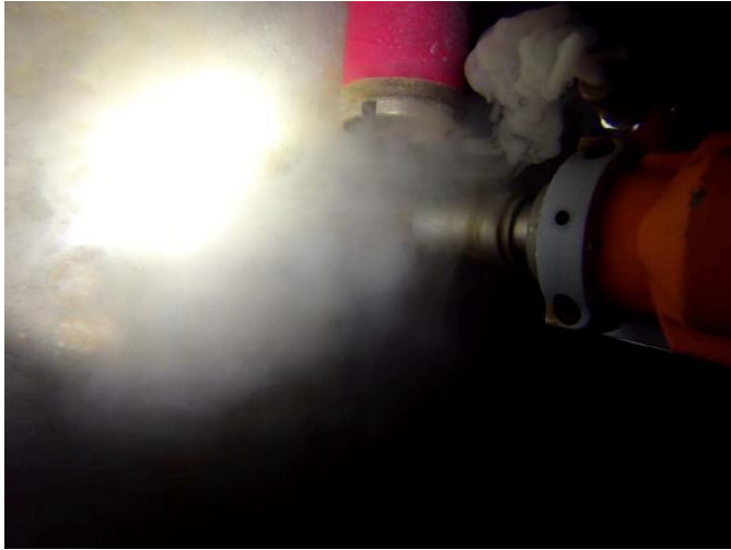
9.池底鑽孔作業
