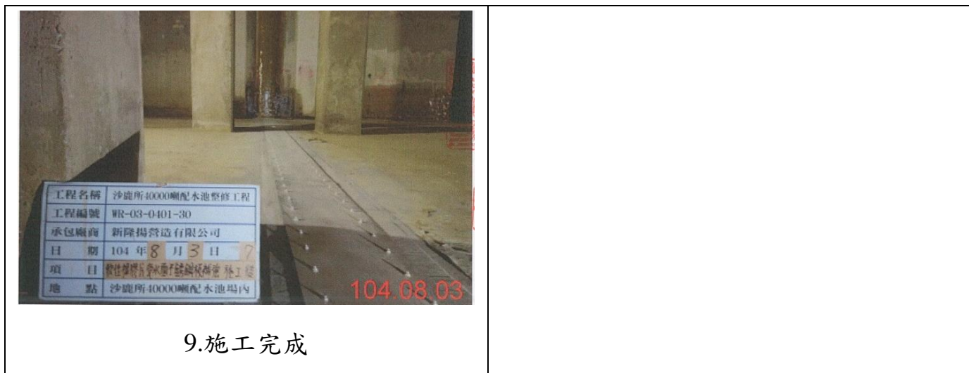
圖 3-2 沙鹿 40,000 噸配水池修復施工照片
