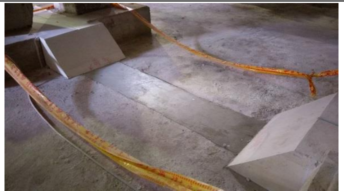
6.柱間填無收縮水泥
