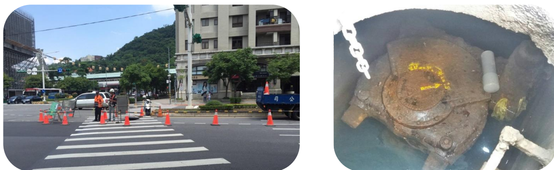
圖 15 操作蝶閥，北投線達停水狀態
