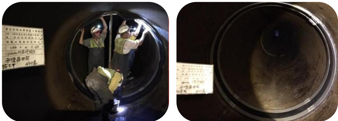
圖 18 施作內套環補強
