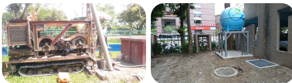
圖 101 地下水井開鑿及共構式儲水槽
