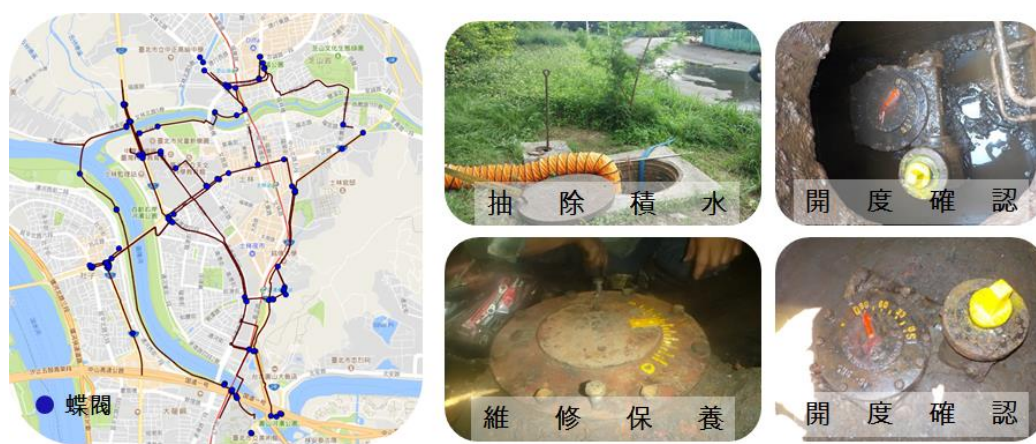
圖 7 北投線蝶閥保養及開度確認
