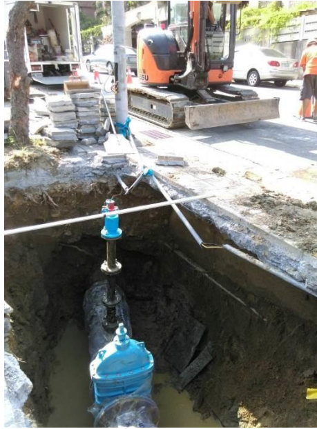
圖 133 在 \phi 400\text{mm} 管線上新增消防栓
