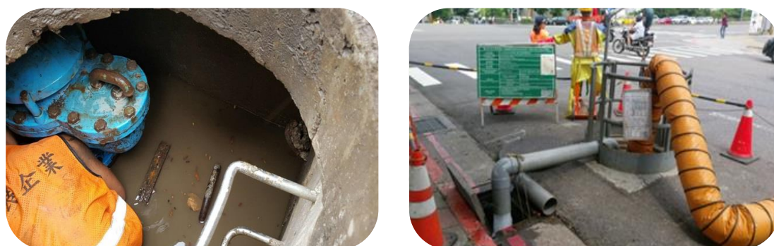
圖 16 拆除排氣閥及管件，抽除管中餘水
