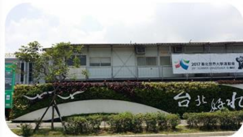
大度加壓站(施工中)
