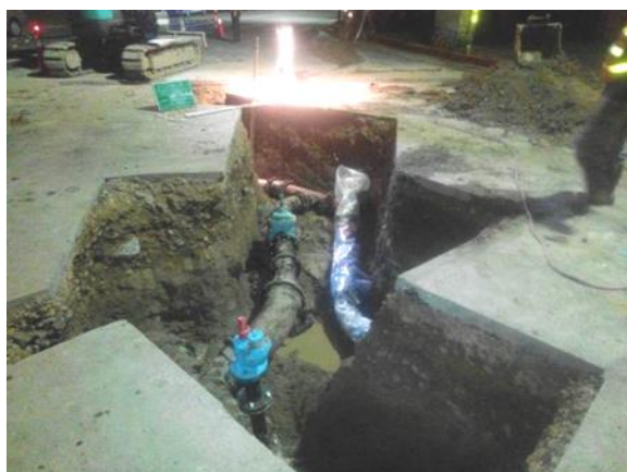
圖 135 新增進水管與出水管連絡
