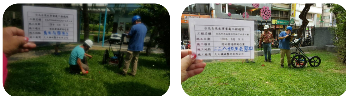
圖 100 以透地雷達作地下管線探測
