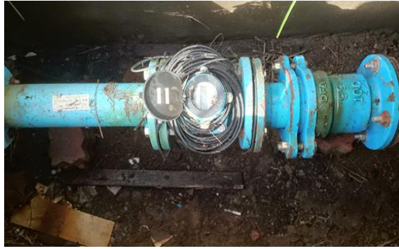
圖 128 大表孔口片安裝完成
