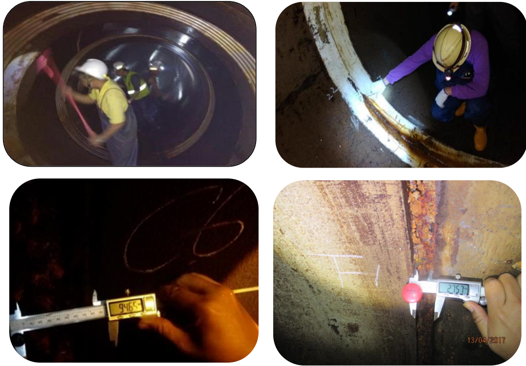
圖 17 管線清洗檢視及接頭量測
