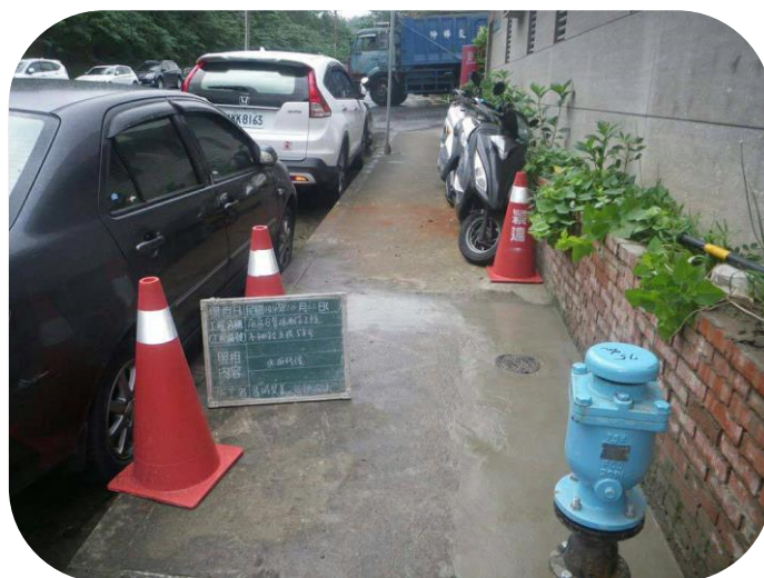
圖 138 木柵路 5 段較高處增設排氣閥
