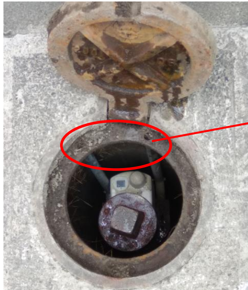
圖 57 制水閥開度監測器透過固定架鎖在制水閥箱框上
