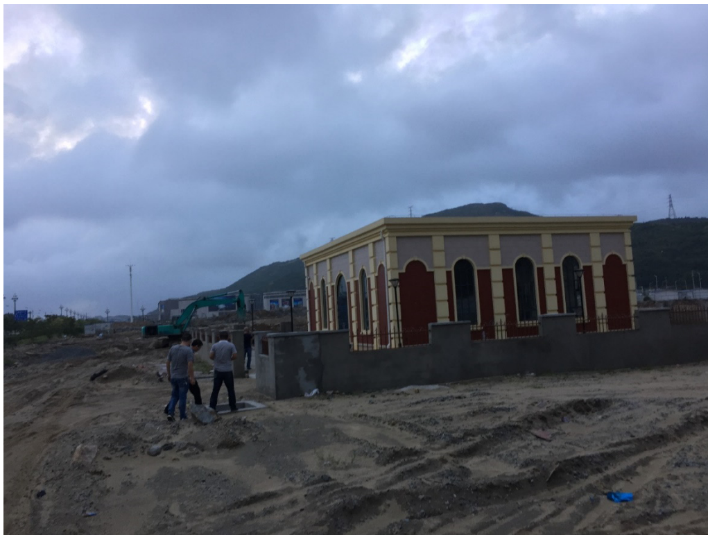
平潭水務公司施工中的抽水站工程
