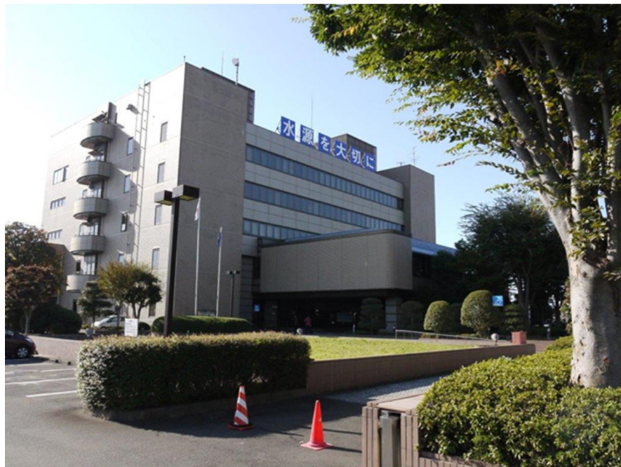
圖一：仙台市水道局全景
