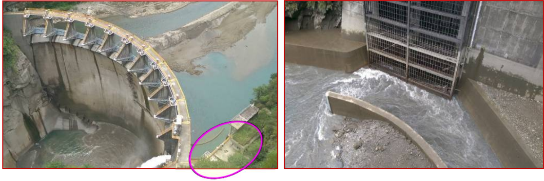
圖 4-6 北水局榮華壩導流牆設施
