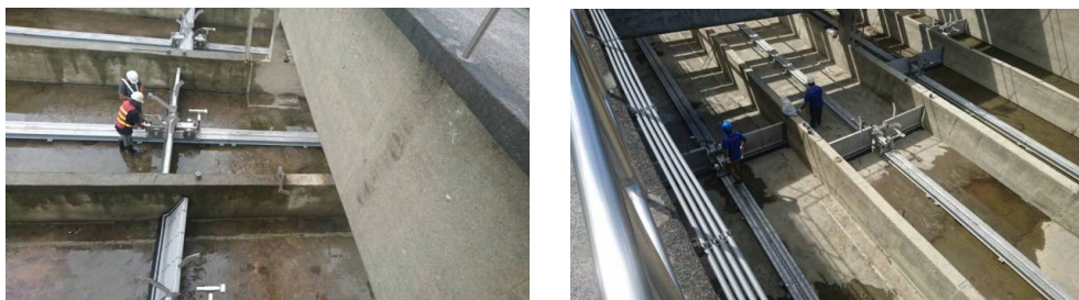
圖 3-20 刮泥機建置施工中照片
