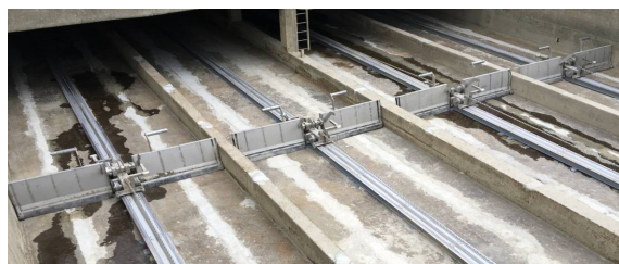
圖 3-21 刮泥機安裝後照片
