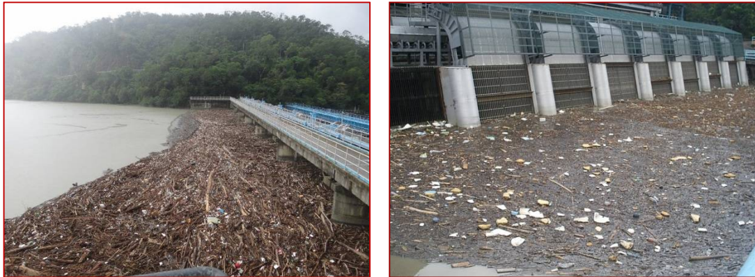
圖 2-22 直潭壩及取水口大量漂流物阻塞
