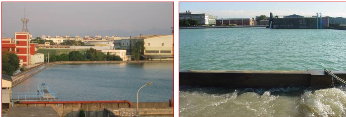
圖 4-5 平鎮淨水場原水調節池(初沉池)
