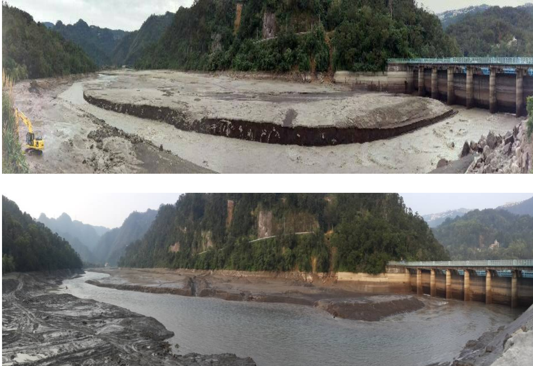
圖 3-8 水庫蓄水範圍第一次空庫清淤 (上)105/1/28 拍攝；(下)105/4/2 拍攝
