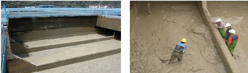
圖 3-18 人工清洗因高濁度累積大量淤泥之沉澱池
