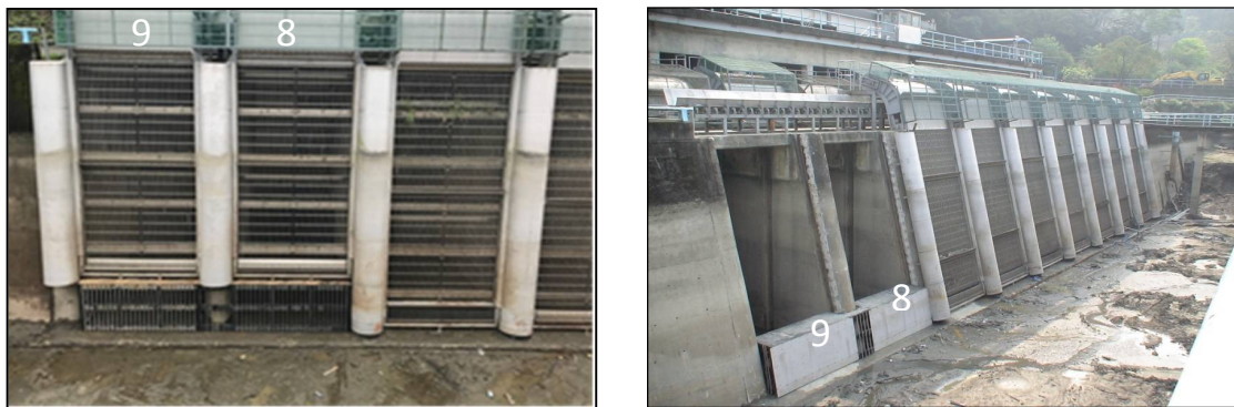
圖 3-5 一原取水口耙污機安裝
