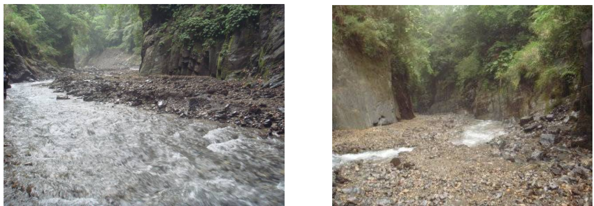
圖 2-15 札孔溪崩塌處下方河道淤積情形
