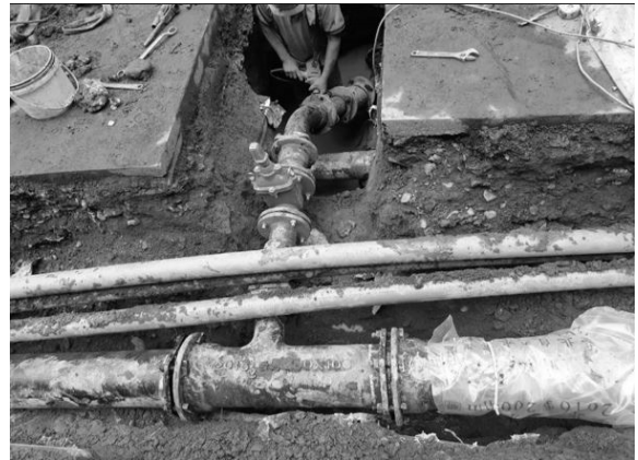
圖 11 自來水管穿越管障
