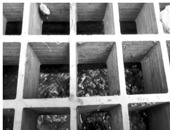
圖 4 水溝內有大量清水流動
