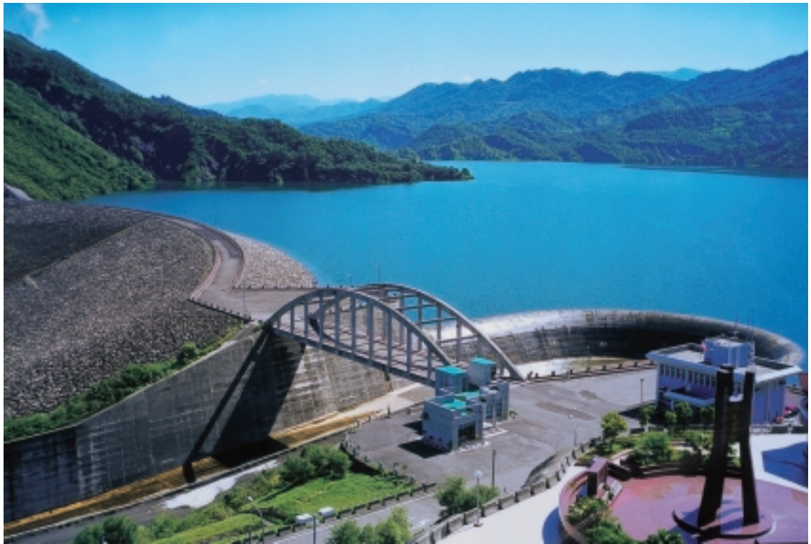
南化水庫大壩全貌
