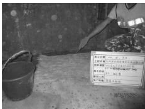
圖 9 內襯 FRP 施工
