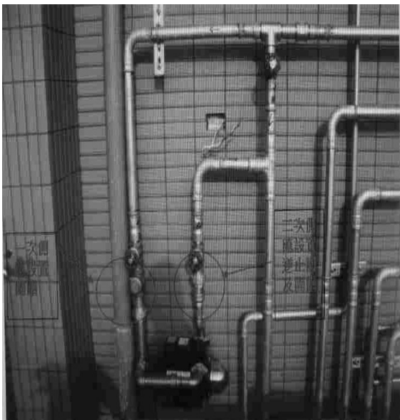
圖 4 泵浦水管給水系統
