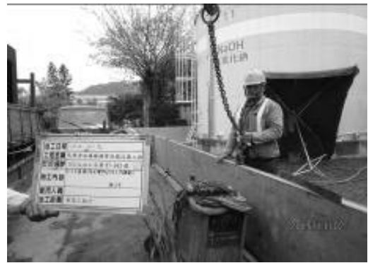
圖 8 不銹鋼防水閘門施工
