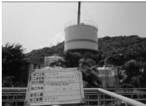
圖 5 新建 300 噸不銹鋼藥槽吊運安裝中
