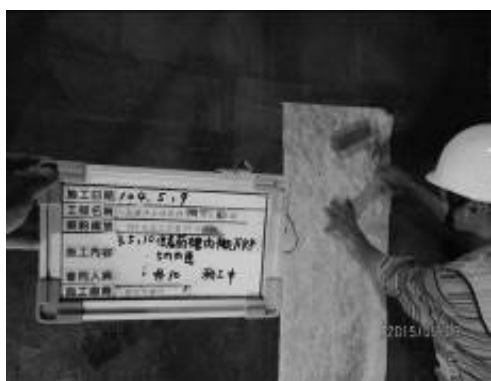
圖 10 內襯 FRP 施工
