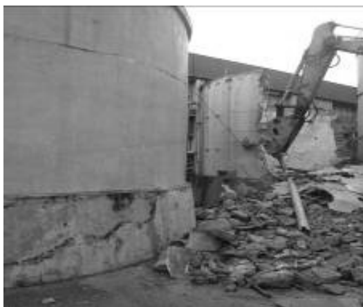
圖 3 拆除藥槽
