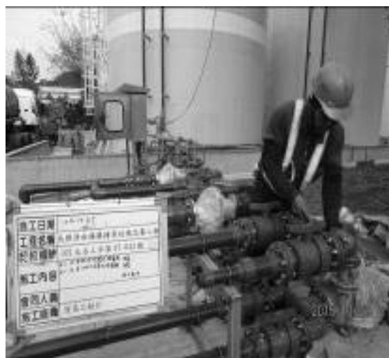
圖 13 進藥及轉運泵浦安裝
