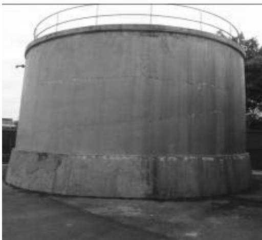
圖 2 100 噸多元氯化鋁(PACI)藥槽 2 槽已老舊逾使用年限，槽體膨脹嚴重變形
