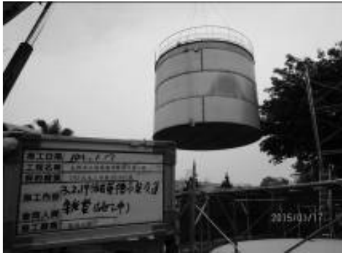
圖 4 新建 150 噸不銹鋼藥槽吊運安裝中
