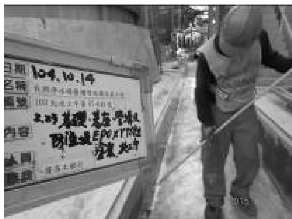
圖 12 管溝新建及 EPOXY 防蝕塗裝
