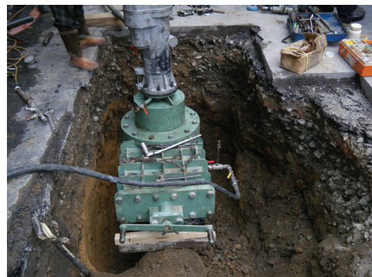
圖 2 不斷水工法之斷管施工示意圖
