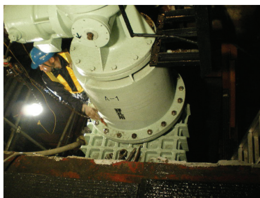
圖 10 安裝穿孔機及穿孔
