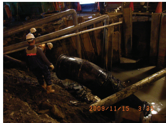
圖 1 傳統工法之斷管施工示意圖
