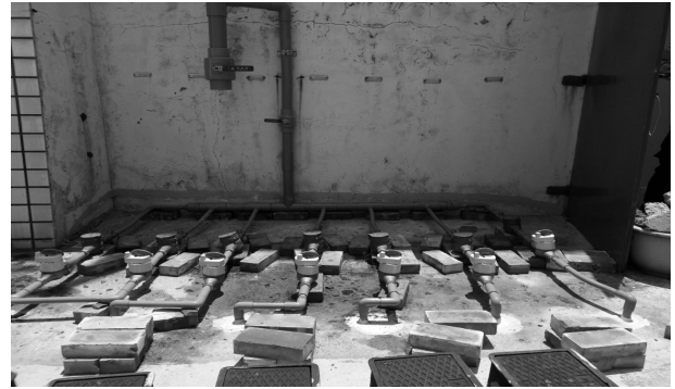
圖 2 T 系統水表及感應器安裝現場
