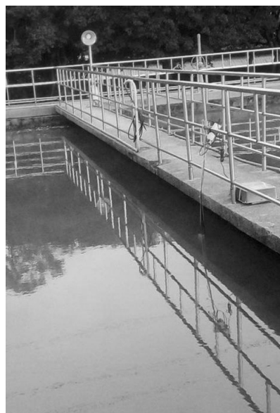
垂置沉澱池中
