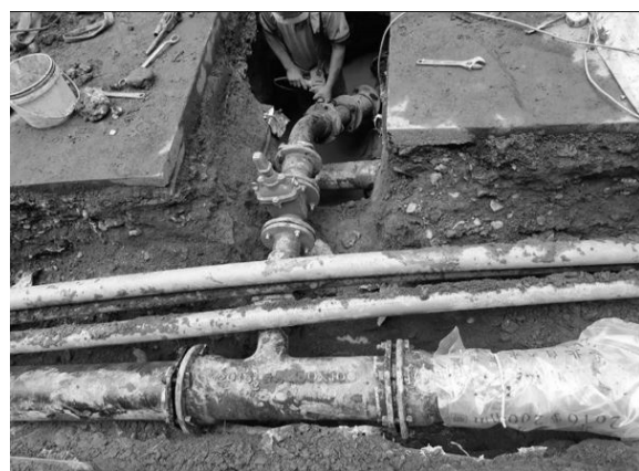
圖 11 自來水管穿越管障
