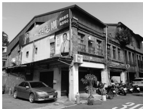
圖 1 小區內現況房屋老舊
