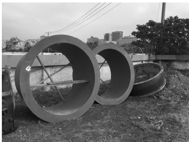
圖 2 \phi 1750\text{mm} SP 特殊接頭 2 只
