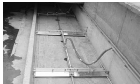
圖 6 吸泥機安裝完成
