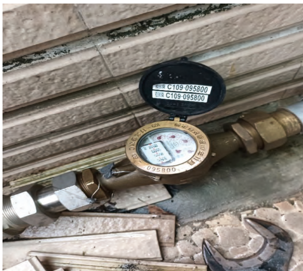
圖 16 協助安裝管內型逆止
