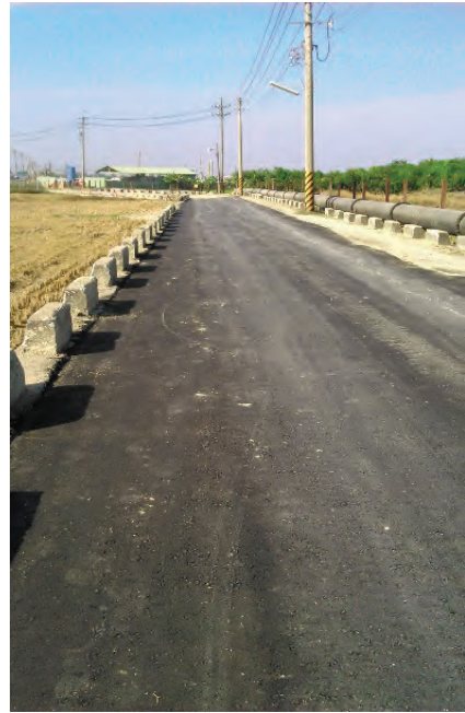
圖 12 臨時 AC 復舊照片
