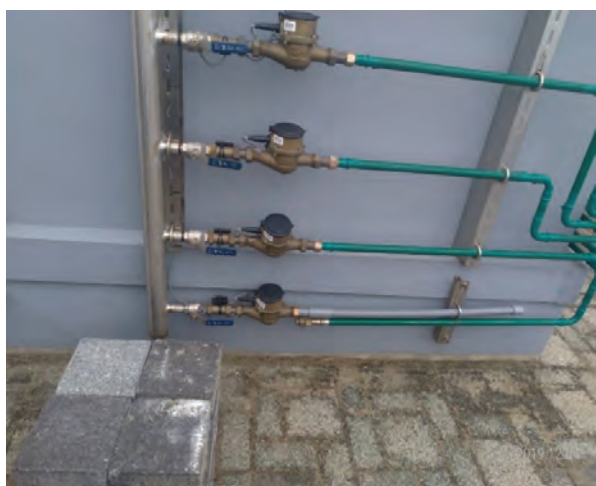
圖 8 水表後 2 尺處封管
