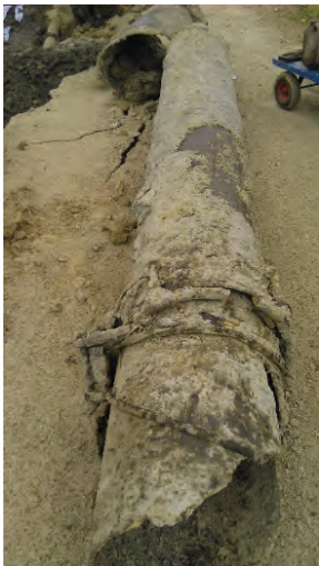
圖 7 挖除舊有之 \phi 700 、400mmPSCP
