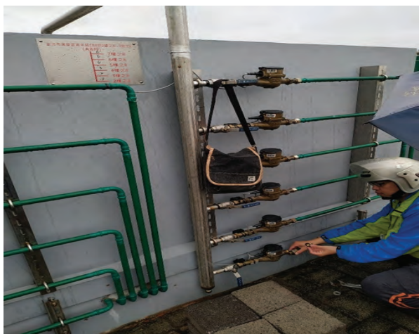
圖 11 協助安裝管內型逆止閥
