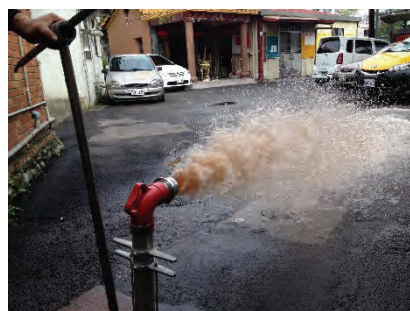
圖 1 現場排水照片
