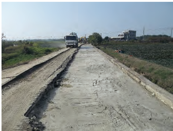
圖 11 管溝開挖回填後需暫時鋪設鐵板供預拌車行走
