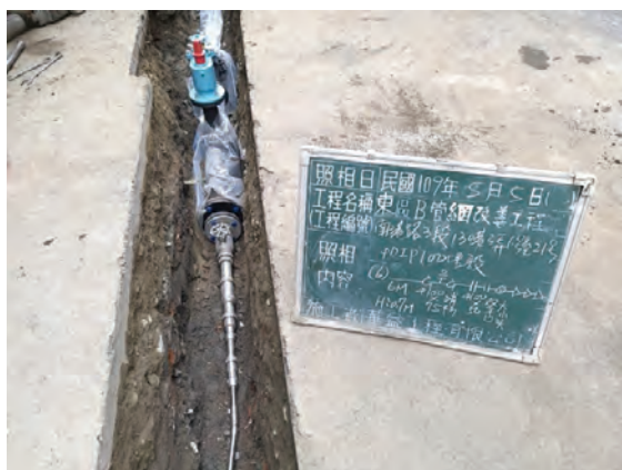
圖 13 管末端改善現場施工照片
