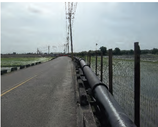
圖 5 \phi 600\text{mm} 臨時管及管架
