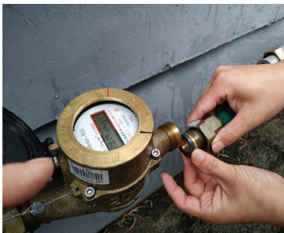
圖 12 協助安裝管內型逆止閥
