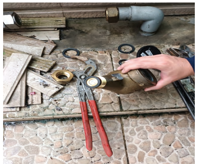
圖 15 協助安裝管內型逆止閥
