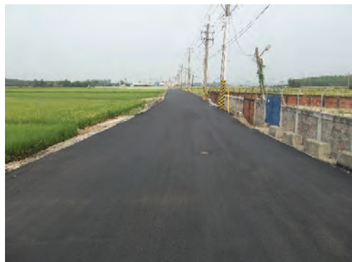
圖 2 施工後照片(起點-隆田加壓站)
