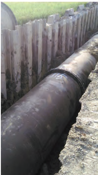
圖 8 管溝開挖及擋土支撐照片
