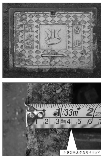
圖 9 加厚(重)型地下式救火栓箱蓋及剖面
