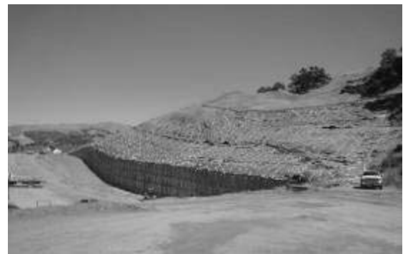
圖 7 右岸坍塌邊坡以地錨暫時穩定
