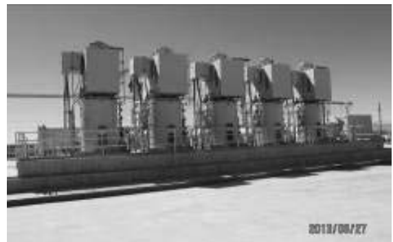
圖 15 5 台 3000HP 豎軸式渦輪幫浦
