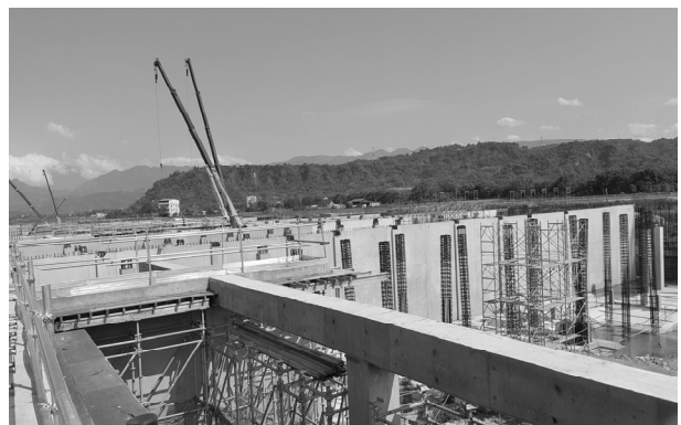
圖 8 前處理設備施工現況圖
