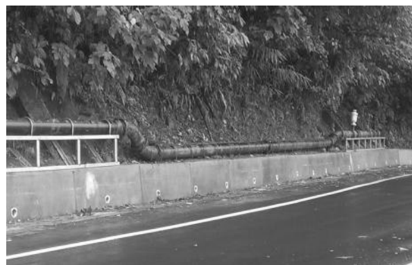
圖 2 新潭路側溝後明管施工
