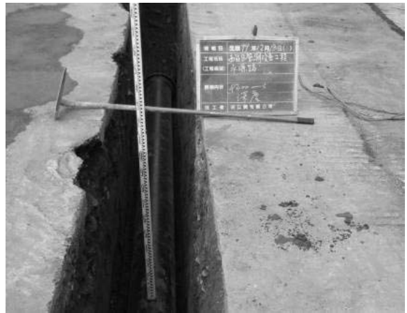
圖 7 水源路抽換配水管
