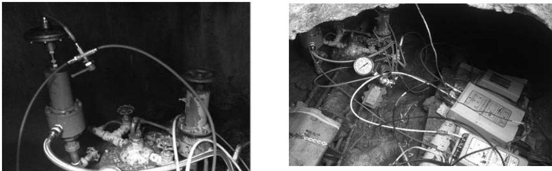
圖 6 現場設備安裝照片
