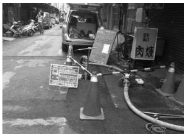
圖 5 C 級計量表進水至消防栓
