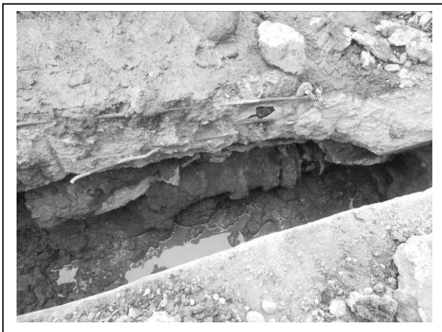
圖 4 暫於漏水管段之前端管以盲蓋封閉
