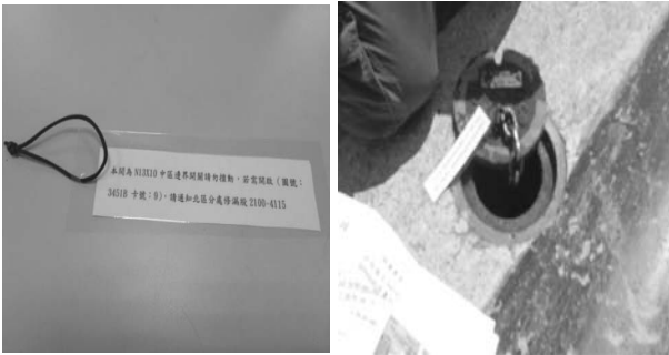
圖 17 中區邊界制水閥內安裝警示牌
