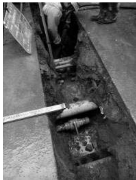
圖 18 斷除不明(舊)管
