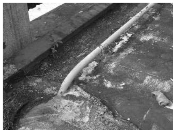
圖 3 舊有用戶下水管（暗管）
