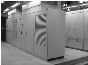
未設變頻器之加壓系統（管網常遭受突增壓力衝擊）
