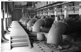
圖 9 北水處採用變頻器及回授訊號控制加壓泵站，讓輸出水壓較為平緩
