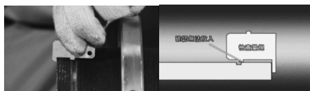
圖 7 切管完成檢查
