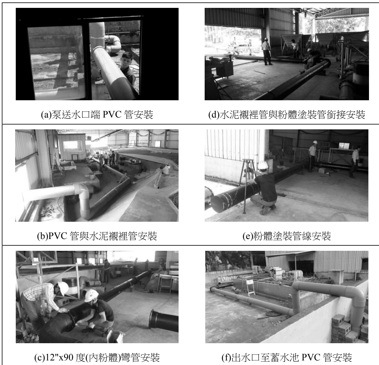
圖 5 試驗管路組裝過程
