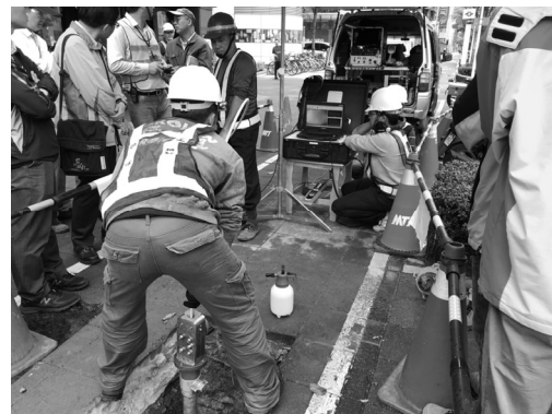
圖 11 內視鏡漏水檢測情形
