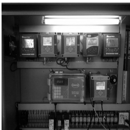
圖 4 取水口設置原水水質連續偵測器
