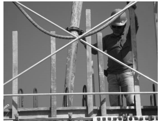
圖 3 以 4 吋鋼管伸入池牆澆置情形
