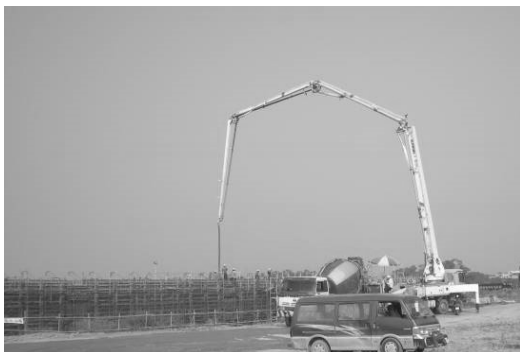
圖 1 一般澆置採用之軟管澆置情形
