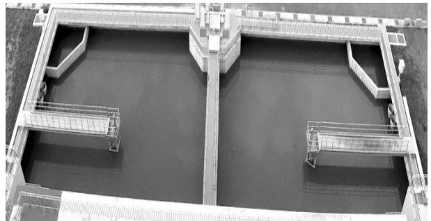
圖 12 出水池完工照
