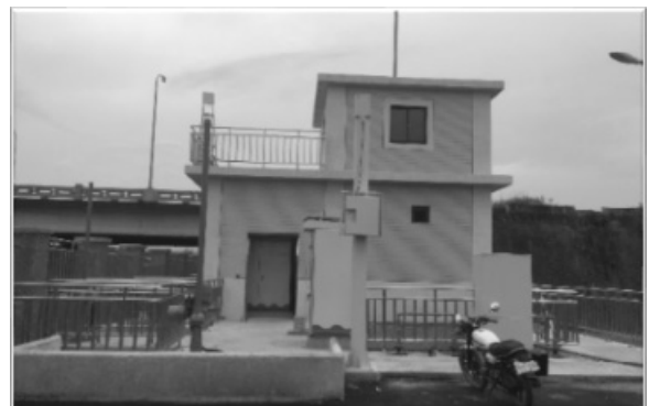
圖 8 取水口完工照
