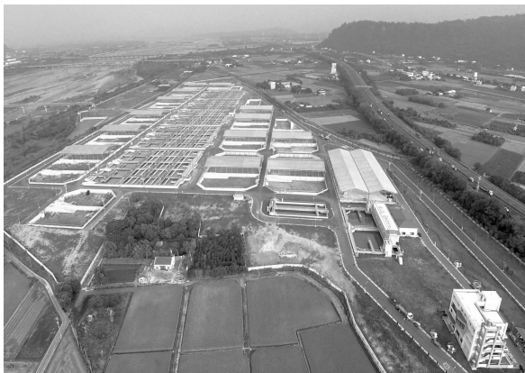
圖 18 完工後全景照
