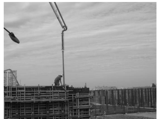
圖 4 以 4 吋鋼管伸入池牆澆置情形
