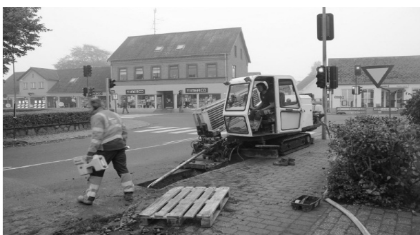
圖 19 HDPE 潛鑽工法
