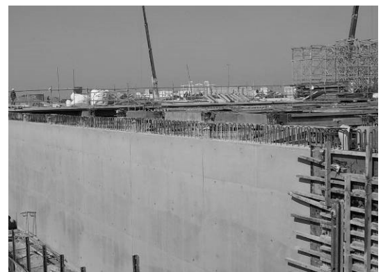
圖 7 清水池池牆以 4 吋鋼管一次澆置之完成面
