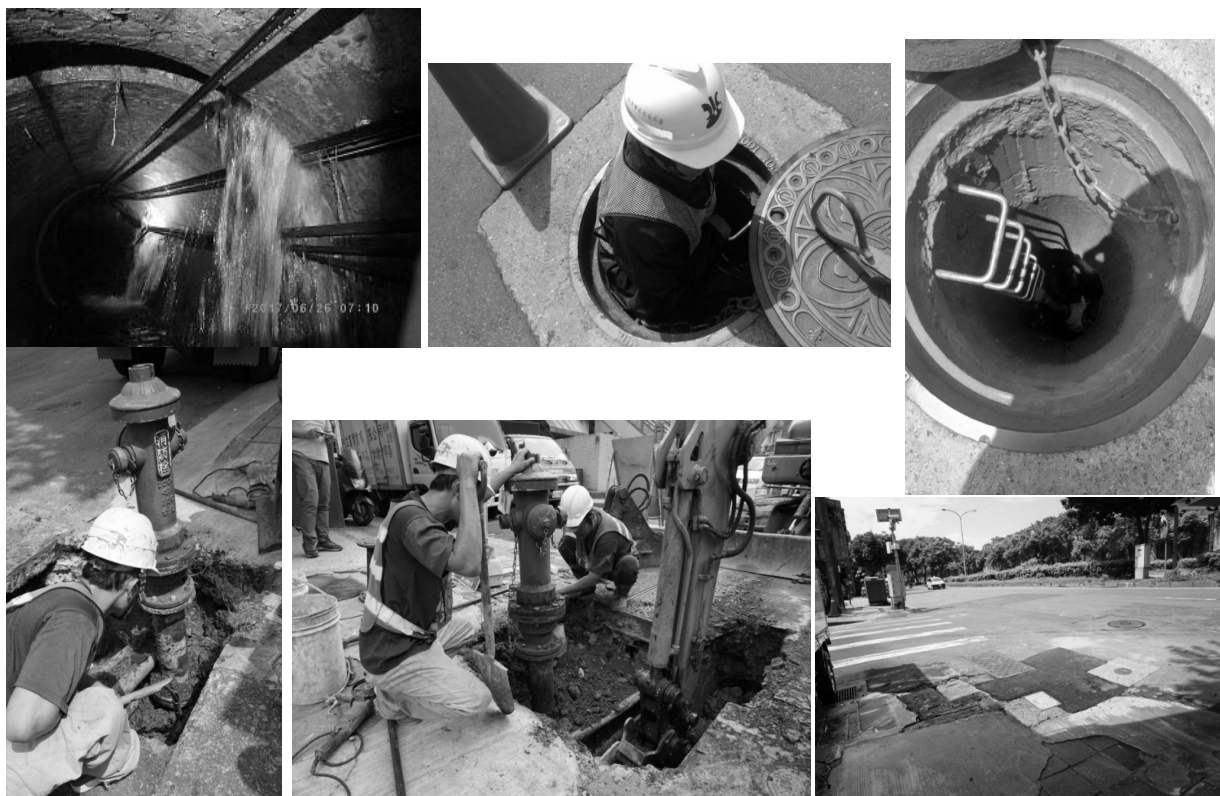
圖 3 萬華區德昌街口渠道內漏水探測及修復過程
