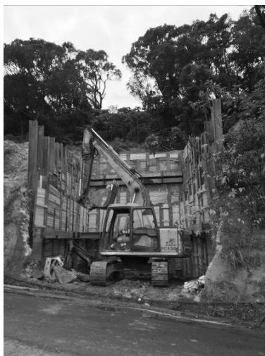
圖 14 第三平台將既有擋土牆拆除後開挖施作擋土設施
