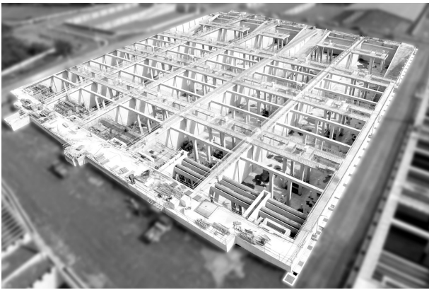
圖 9 初沉池施工照
