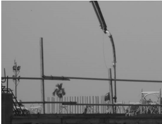
圖 8 以軟管對接 4 吋鋼管
