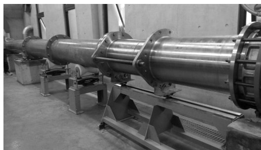
圖 13 安裝專用伸縮管照片
