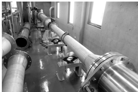
圖 15 自來水流量計校驗設備裝置完成照片
