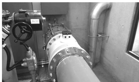
圖 11 以串聯方式安裝標準流量計照片
