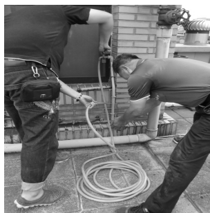
A2 棟屋頂私設水栓
