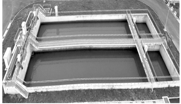
圖 11 量水槽完工照
