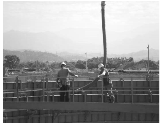
圖 2 一般澆置採用之軟管澆置情形
