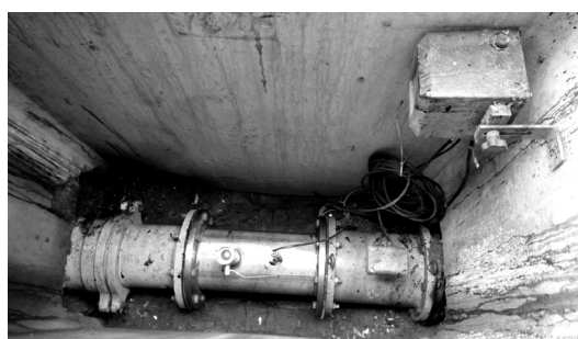
圖 1 小區計量窰井安裝流量計
