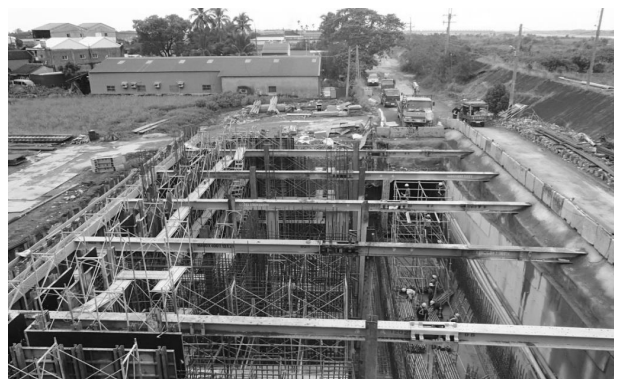
圖 7 取水口施工照
