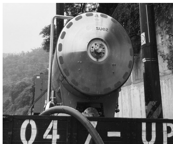
圖 16 以加壓設備將碎冰灌入消防栓
