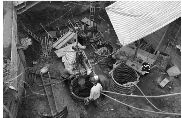
圖 15 平台基樁機械空間不足改以人工挖掘
