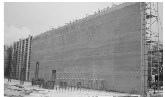
圖 6 原水調節池池牆以 4 吋鋼管一次澆置之完成面
