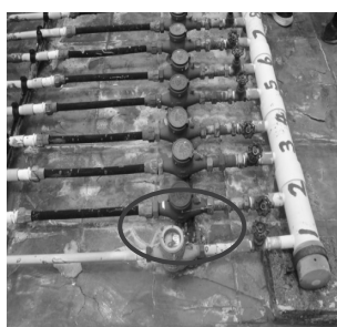
C2 棟屋頂增設一栓私表
