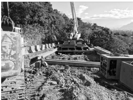
圖 13 第二平台施作構台為替代道路供車輛通行
