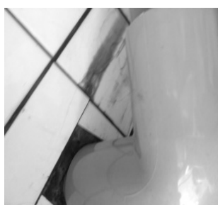
B1 棟總表後於接水槽內套管滲漏
