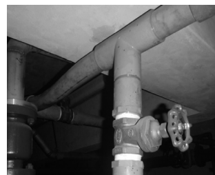
C1C2 地下受水管設聯通管
