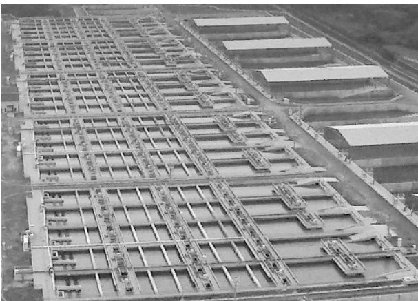
圖 10 初沉池完工照
