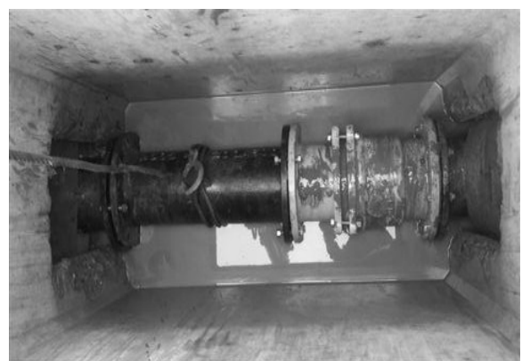
窰井內水表組換裝為雙突緣短管
