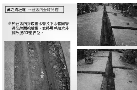
圖 4 揚水管及下水管全線開挖照片
