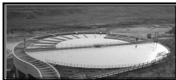
圖 3 紅山嘴水電站排砂漏斗圖
