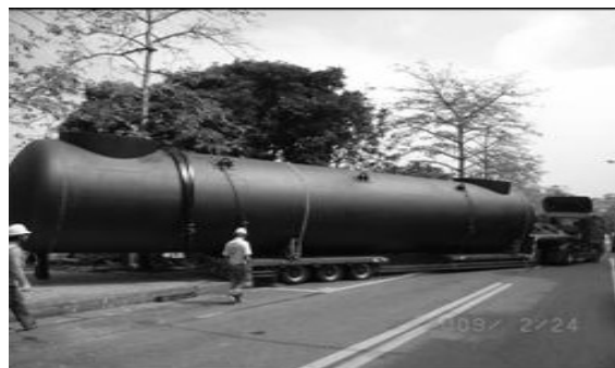
圖 6 維生貯水槽及配水池取水站
