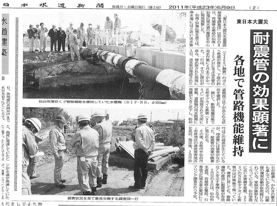
圖 1 日本水道新聞報導 NS 型 DIP 等耐震管在東日本大震災效果顯著(資料來源:日本水道新聞)
