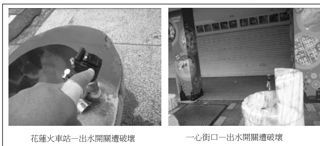
圖 5 自來水生飲台開關損壞
