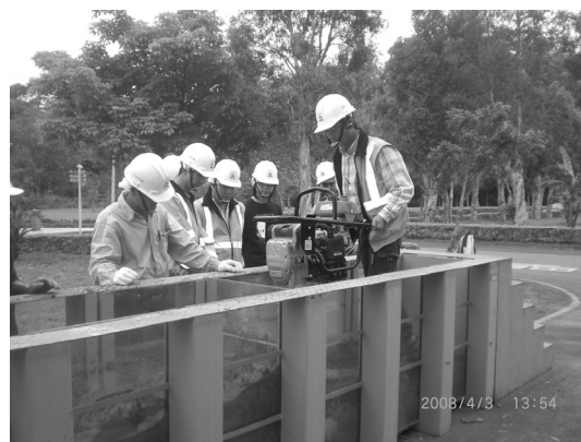
圖 7 跳躍式夯壓機
