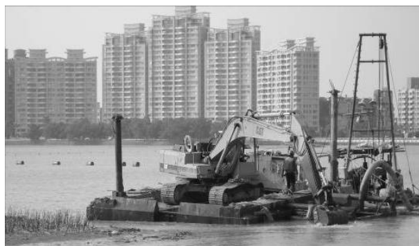
圖 2 鏟底泥挖土機照片
