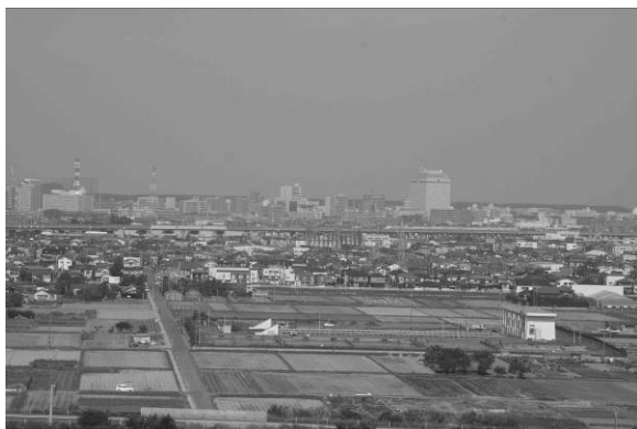
圖 35 由高架配水塔上望出
