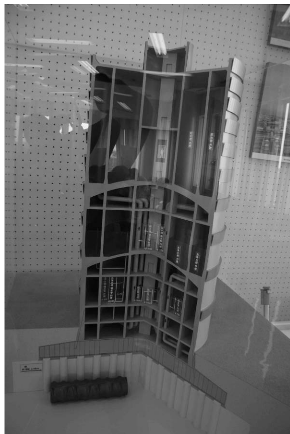
圖 34 高架配水塔模型
