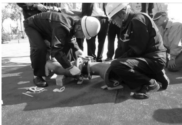
圖 28 彎管接管情形
