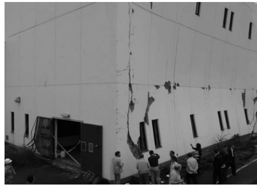
圖 44 遭海嘯破壞的淨水設備廠
