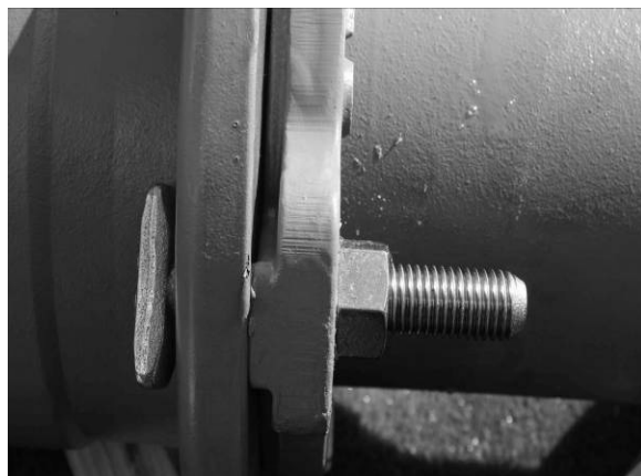
圖 30 彎管裝設好後膠圈無露出
