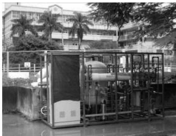
混凝、砂濾、UF 及 LPRO 設備組裝前
