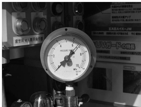
圖 13 PE 管水壓試驗
