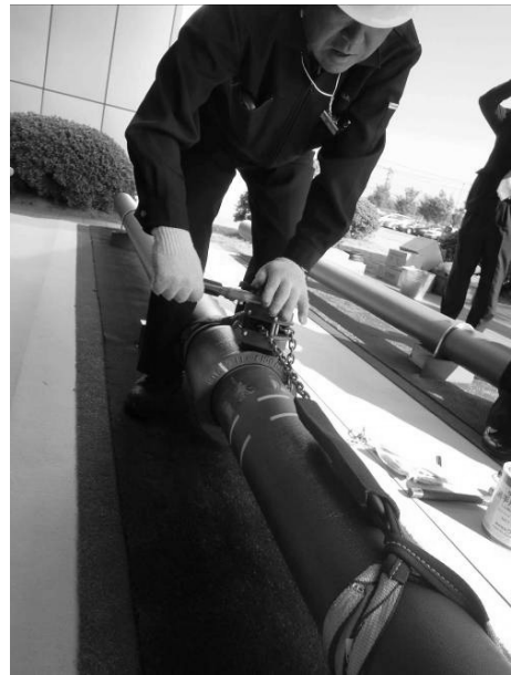
圖 26 管線接合工具及操作方式
