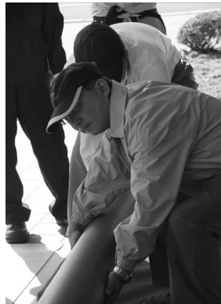
圖 27 測試接合好的管線抗拉強度
