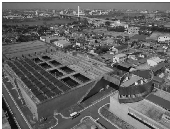
圖 32 濾水池上加裝太陽能板
