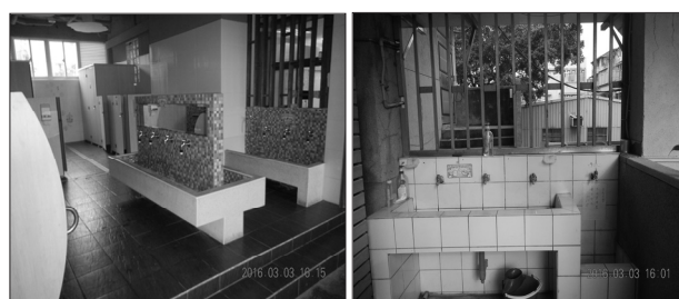
圖 4 學校供水站取水點勘查
