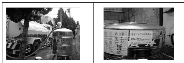
圖 7 臨時供水站補水作業
