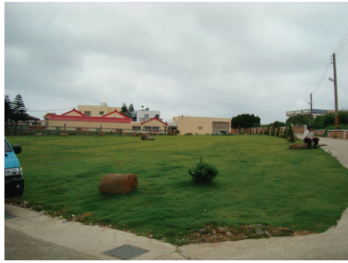
圖 8 離島地區大片美麗平坦草原需澆水養護，於水表前私接竊水
