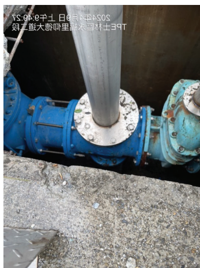
圖 4 永嶺配水池重力進水十字濾管上蓋改裝為排水管(照片：北水處葉信孝提供)
