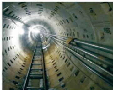
輸水幹管潛盾工程
