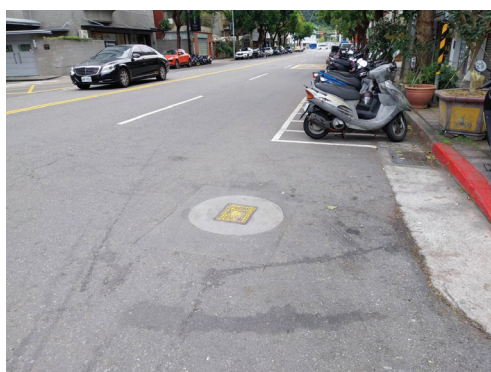
圖 10 分 2 段施工圓形切割工法完成
