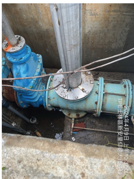
圖 5 新下竹林配水池重力進水十字濾管上蓋改裝為排水管(照片：北水處葉信孝提供)
