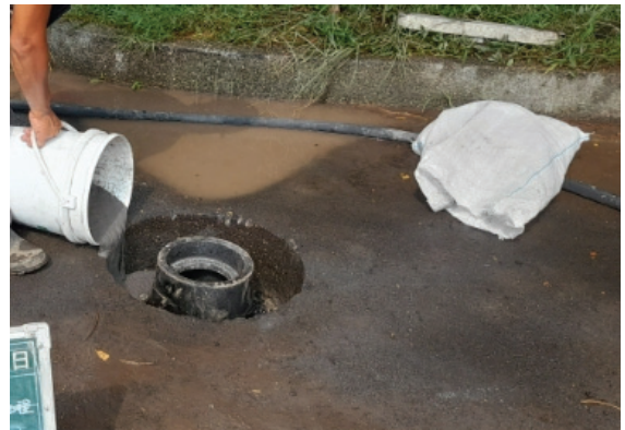
圖 5 澆置回填料
