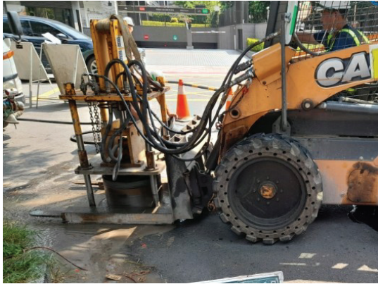
圖 2 圓形切割機定位後進行切割
