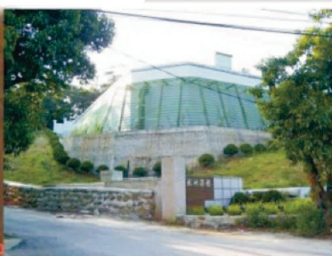
北水處伸仗板5,000噸水池
