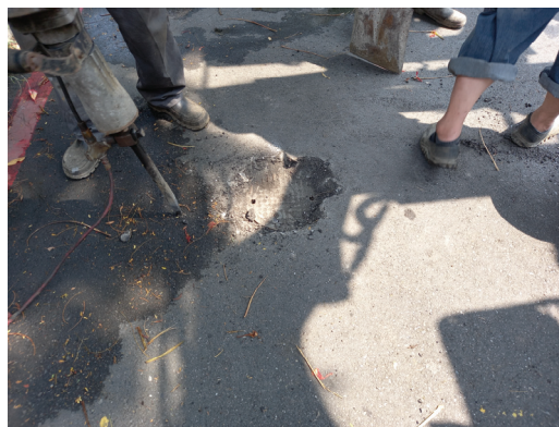
圖 1 手持破碎機鑿除 AC 露出手孔中心
