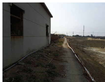
圖 7 用戶外線水表前端，遭私接至魚塢養殖場竊水
