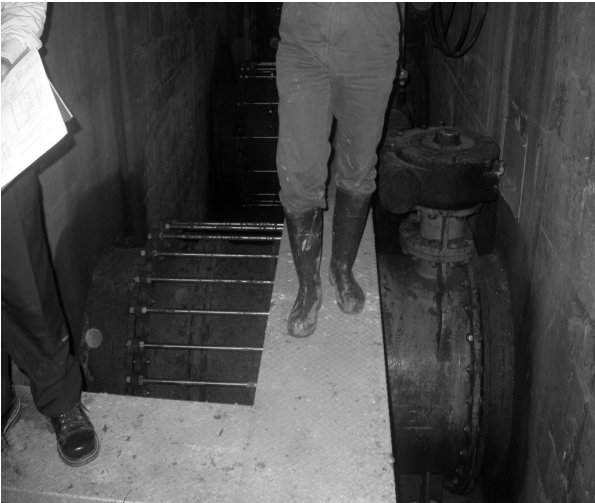
圖 7 4 組 \phi 1,200\text{mm} 進水管窰井
