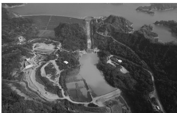
圖 3 南化水庫清淤暫置土堤及過濾池鳥瞰
