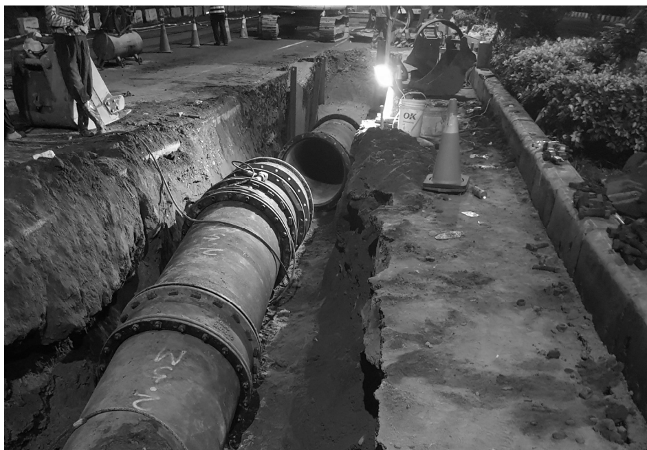
圖 10 107.05.03 管線進行管線汰換
