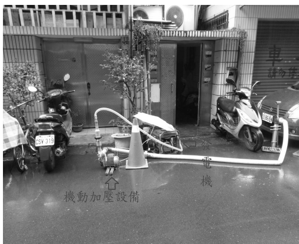
圖 3 106 年 12 月 7 日以機動加壓設備灌水情形
