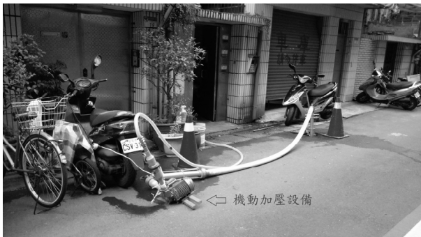
圖 6 106 年 12 月 9 日再次以機動加壓設備灌水情形
