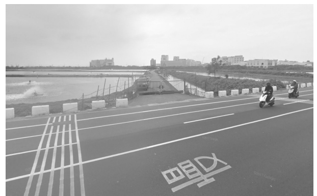
圖 3 路面無漏水現象
