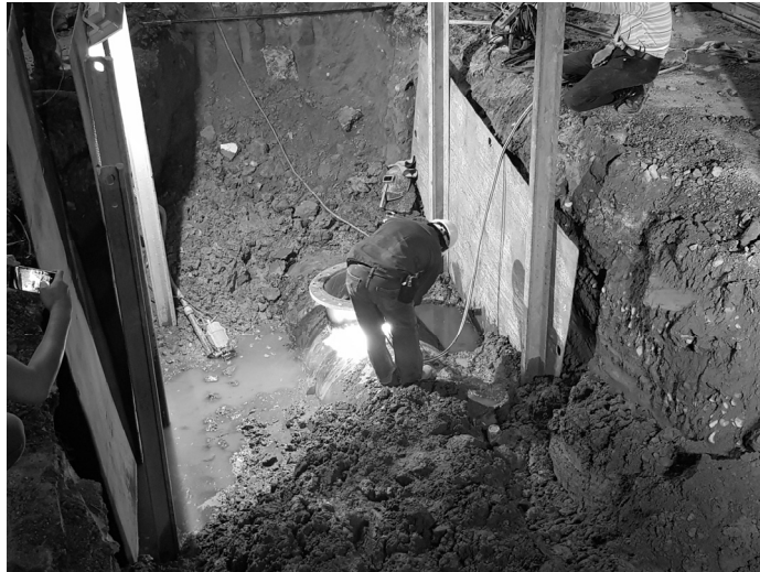
圖 6 107.04.27 焊道滲漏搶修
