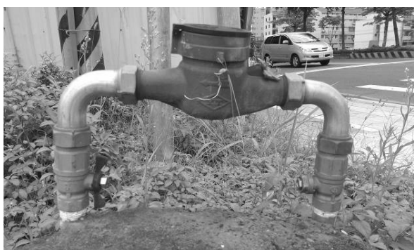
圖 11 止水栓具逆止及微進水阻止功能
