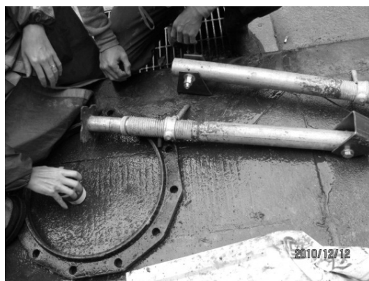
圖 2 改良式可調鋼管支撐現場組裝
