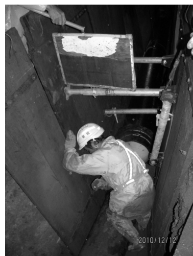
圖 5 鉸接端處懸起鋼管支撐
