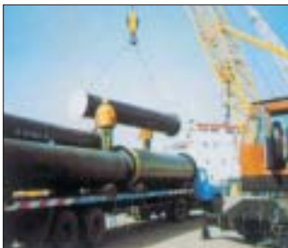
外銷DN1200x6M直管吊裝作業
