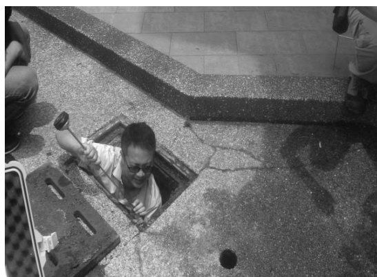
圖 5 聽音檢測竊水管線由水溝內穿越
