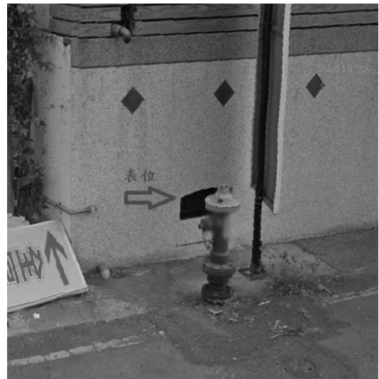
圖 1 現場表位及藥水管
