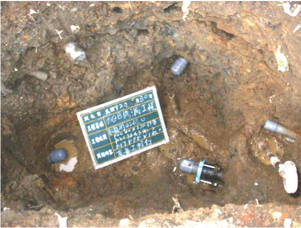
圖 6 只在開挖點封管，未斷除接合管，形成盲腸管
