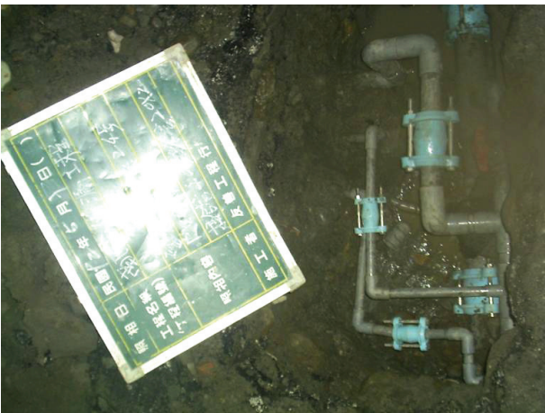
圖 6 只在開挖點封管，未斷除接合管，形成盲腸管
