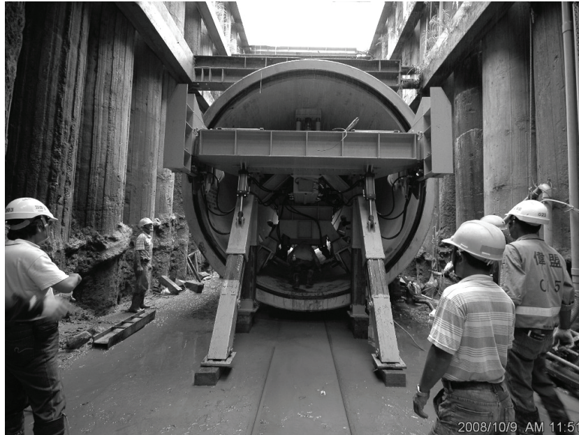
圖 2 直潭第二條原水輸水路隧道工程穿管施工照片
