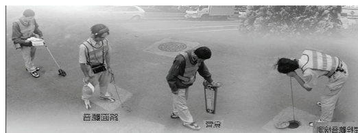
圖 1 聽音檢測作業
