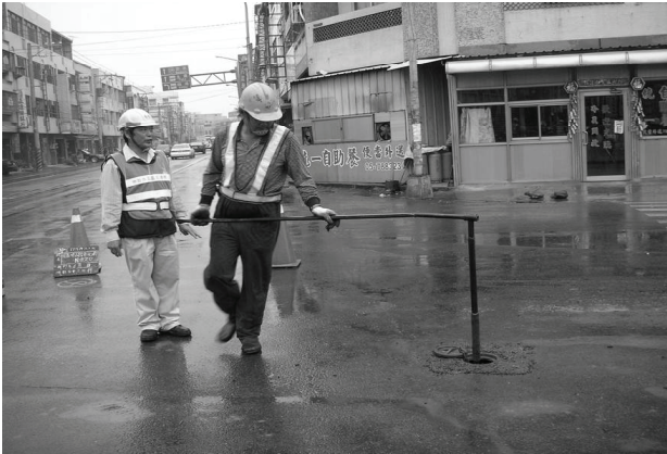
圖 8 開啟 200m/m 制水閥
