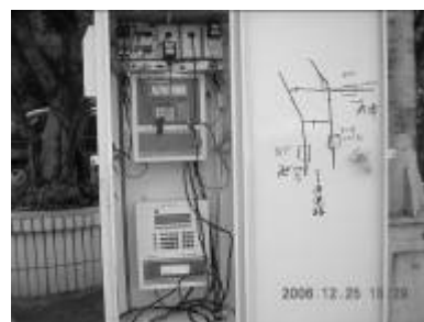
圖 3 線上超音波式主機，一台主機可同時紀錄兩管數值，各具流量與壓力，並可即時同步傳輸
