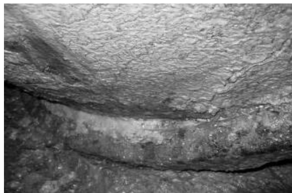
圖 23 鉛塊敲入後止水相片
