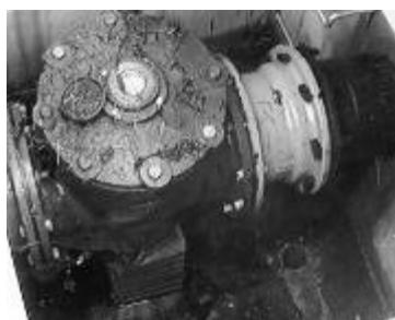
圖 2 螺旋電子式水量計需停水、斷管裝設（適用單一管徑）
