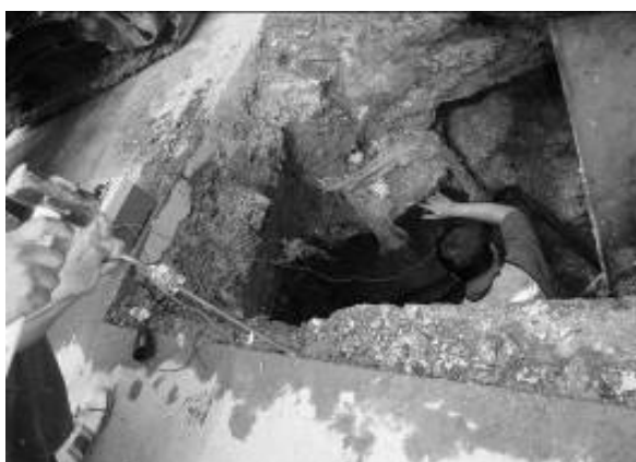
圖 17 使用聽音檢測儀器
