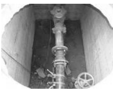
圖 5 場內配水總量計量管改設
