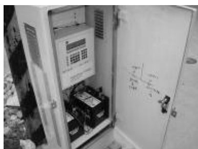
圖 7 線上型超音波流量計與小區傳訊箱
