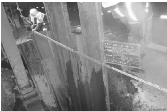
圖 19 管溝開挖長約 4.5M
