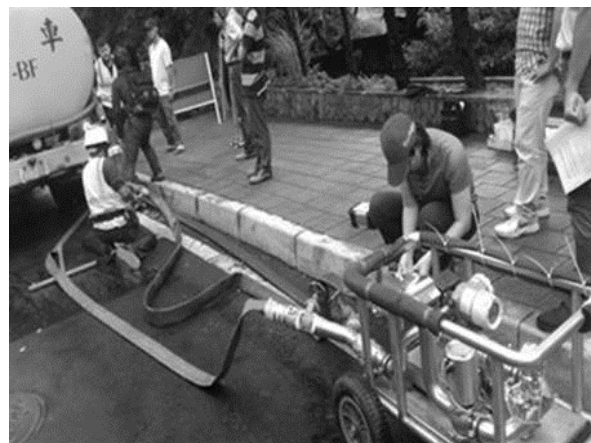
圖 11 洗管排水取樣
