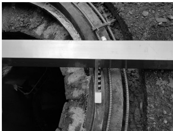
圖 11 基座調平及填縫施作
