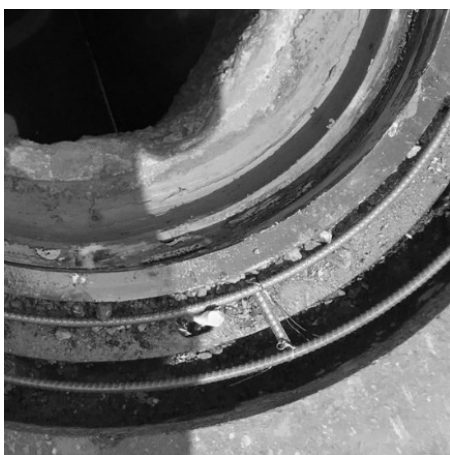
圖 13 鋼筋鎖固施作
