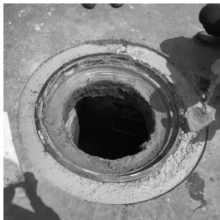
圖 14 基座外側澆置施作
