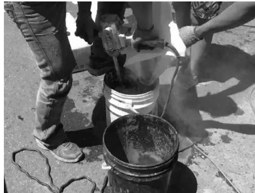
圖 9 樹脂水泥混合碎石級配攪拌施作
