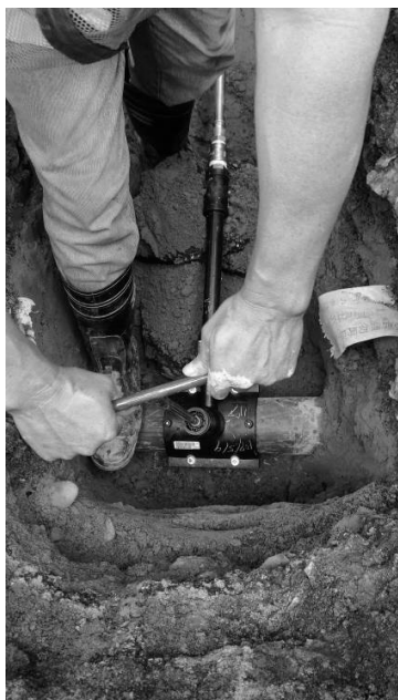
圖 16 以六角板手將鞍座內含之切刀旋轉於 HDPE 配水管鑽孔通水
