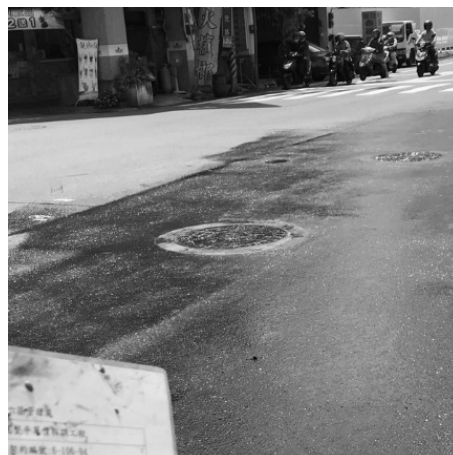
圖 16 人孔蓋安放施作
