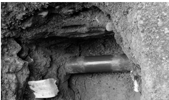
圖 11 將與鞍座接觸面刮除光滑
