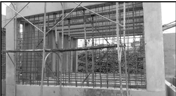
圖 6 集水廊道下構完成
