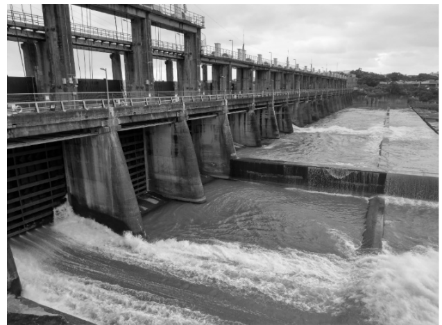
圖 9 鳶山堰排洪操作
