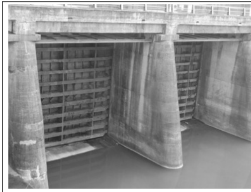
圖 2 排砂道閘門門扉現況
