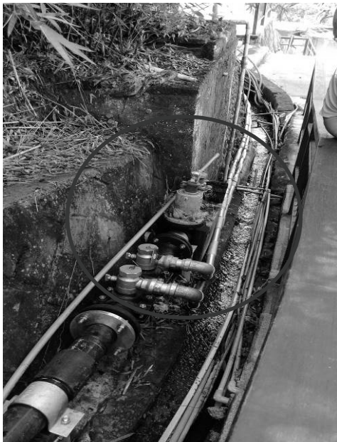
圖 2 HDPE 管 DIP 預留處施作鞍帶接水
