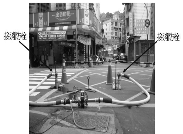
圖 3 「巷弄直接法」施測現場
