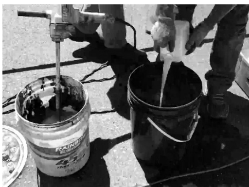
圖 8 樹脂水泥攪拌施作
