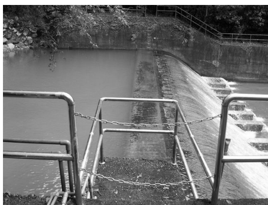
圖 3 鹿角坑第一加壓站取水堰
