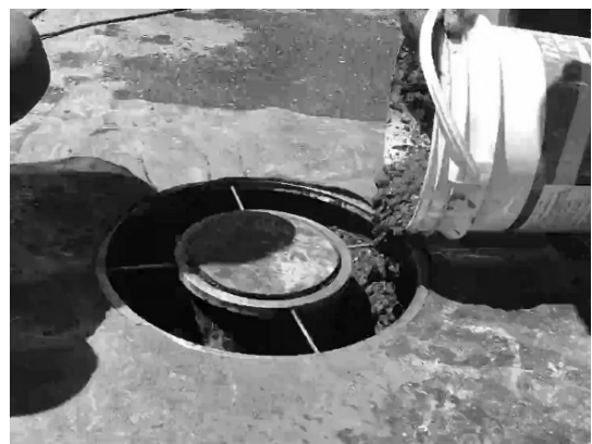
圖 10 樹脂水泥澆置施作
