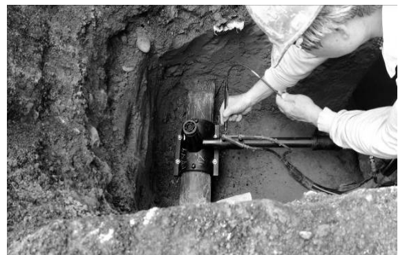
圖 15 掃描管件條碼主機決定加熱時間
