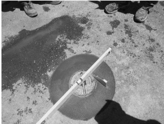
圖 17 NSC 工法施作完成
