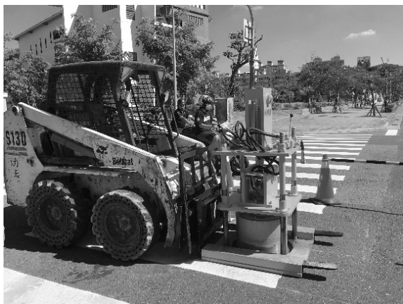
圖 4 圓形切割機(適用制水閥)
