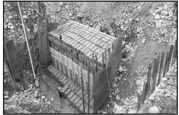
圖 9 濾層石籠鋪設完成
