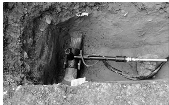
圖 14 給水管管件熔接
