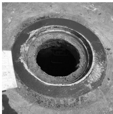
圖 15 外圍澆置抹平施作
