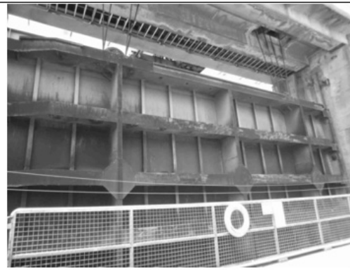
圖 3 排洪道閘門門扉現況
