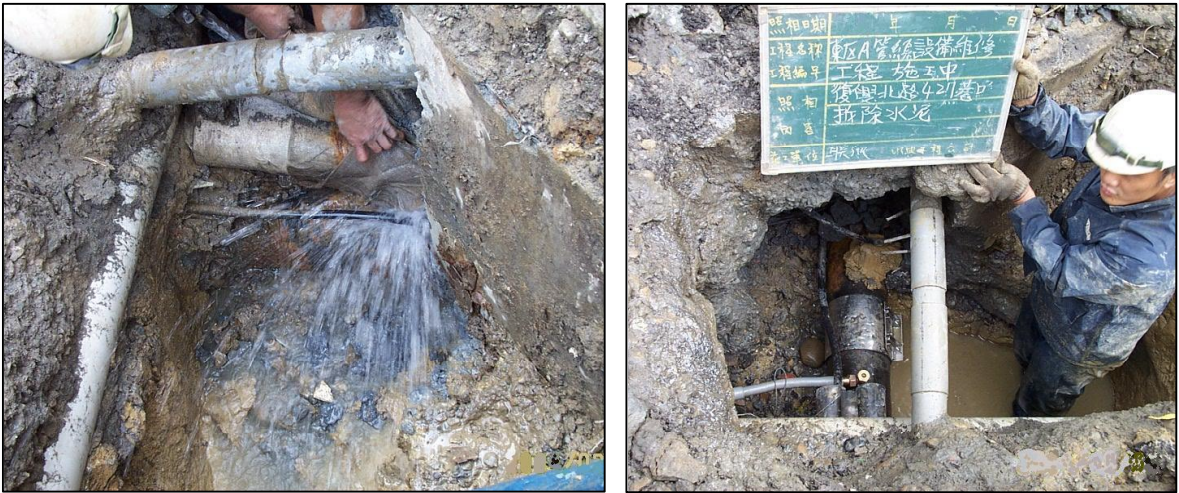
圖 15 左：漏水點開挖 右：修漏作業
