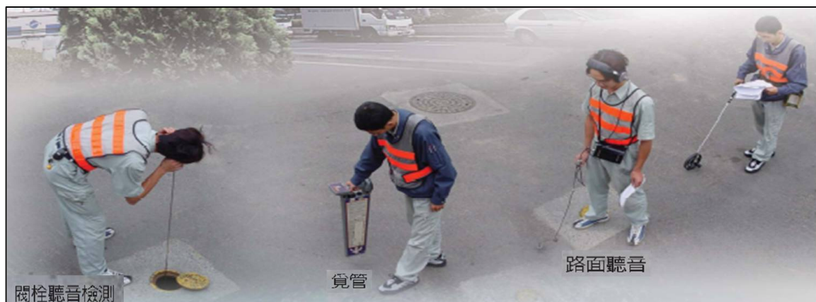
圖 14 漏水檢測作業
