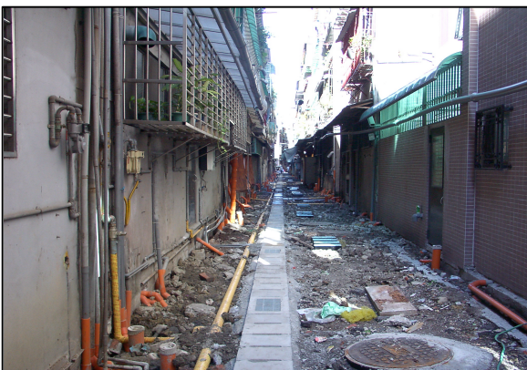
圖 7 防火巷管線汰換
