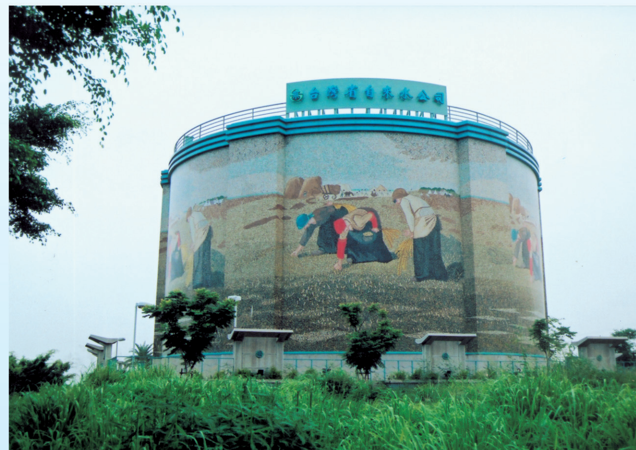
高屏特定區配水池工程
