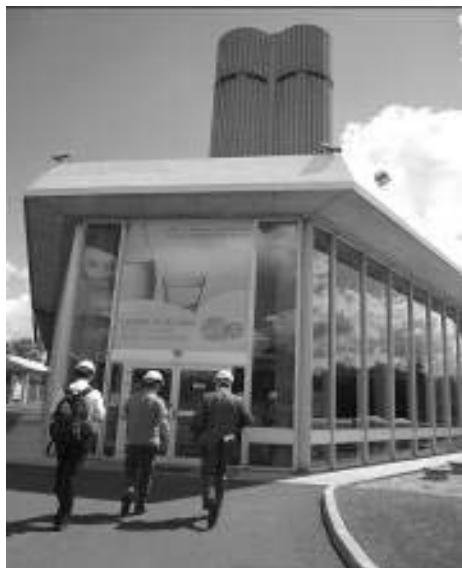
圖 4 淨水場的進流中央控制中心
