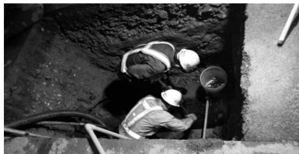
圖 4 再鑿第二孔裝壓力表同時可排水
