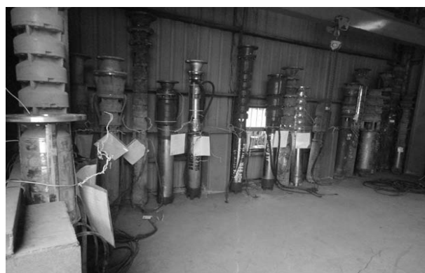
圖 9 深井抽水機倉庫整備及一機三卡管制
