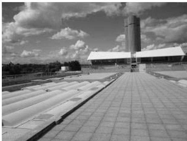
圖 6 淨水設備加蓋避免藻類滋生
