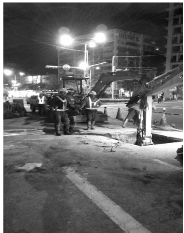
圖 1 抽換管線前，開挖準備鑿孔
