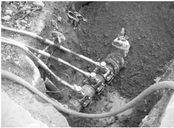
圖 6 新北市永和區中山路 1 段 352 巷施工照片(二)
