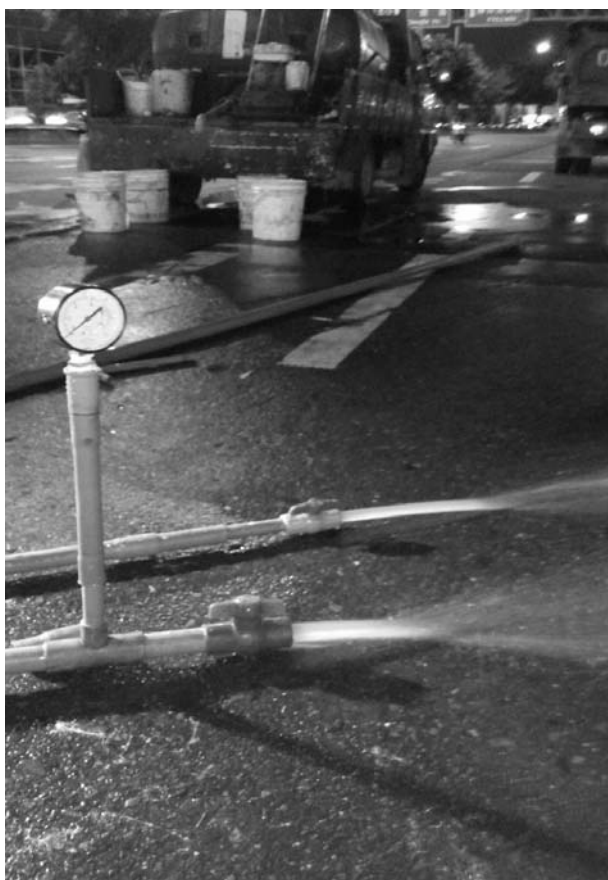
圖 5 裝置完成排水及監看水壓
