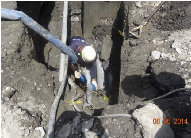
圖 10 既有管線修復施工
