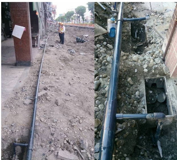
圖 11 凱旋三路臨時管線設置
