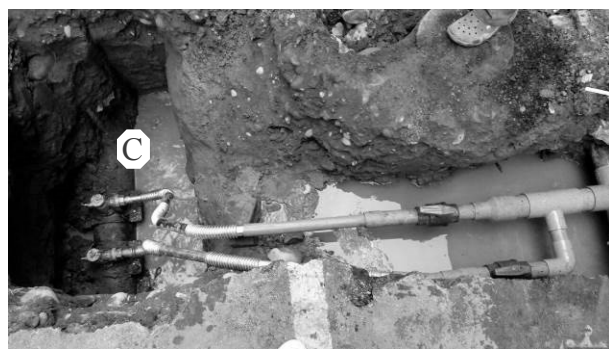
圖 3 無水區內外開挖接通
